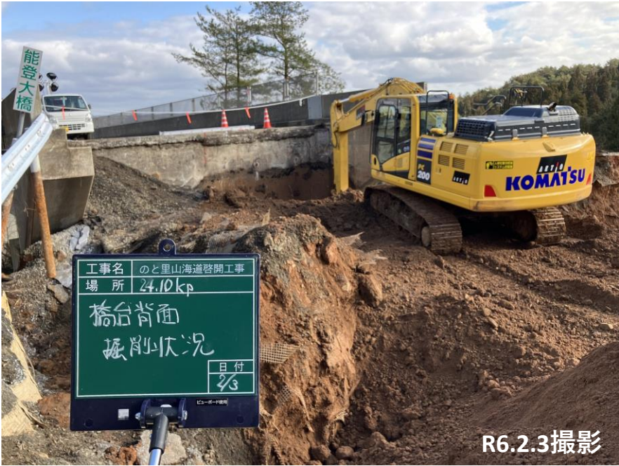
No. 50 橋台背面掘削状況
