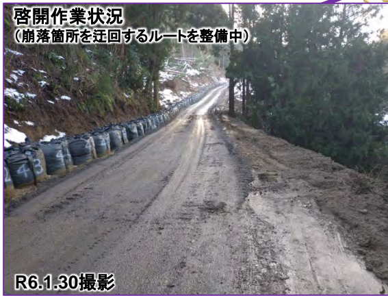
啓開作業状況 (崩落箇所を迂回するルートを整備中)
