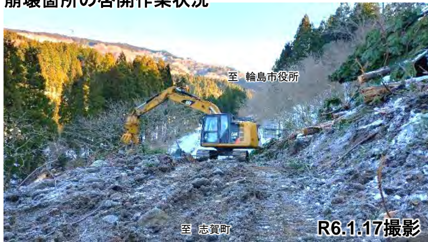
崩壊箇所の啓開作業状況
