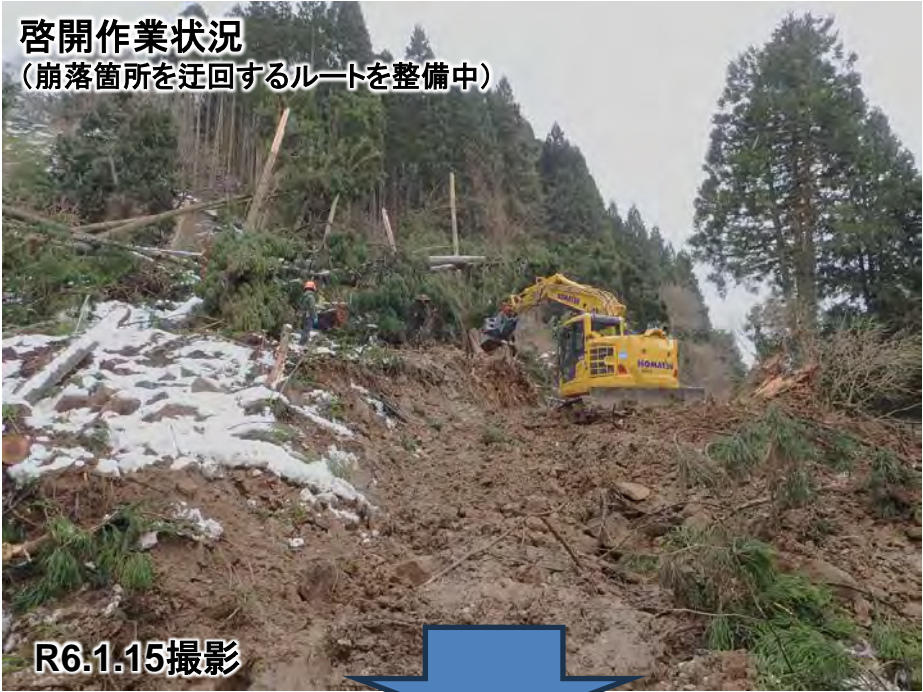
啓開作業状況 (崩落箇所を迂回するルートを整備中)
