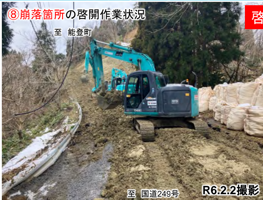
⑧崩落箇所の啓開作業状況
