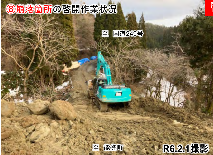
⑧崩落箇所の啓開作業状況
