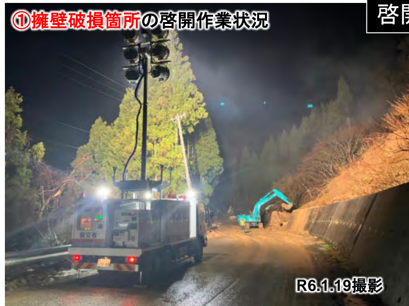
①擁壁破損箇所の啓開作業状況
