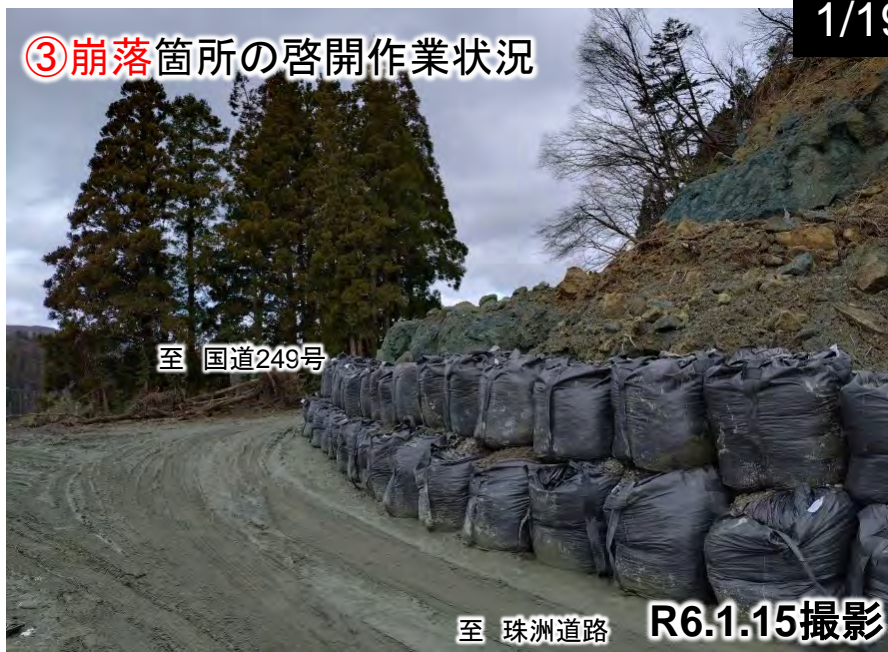
③ 崩落箇所の啓開作業状況
