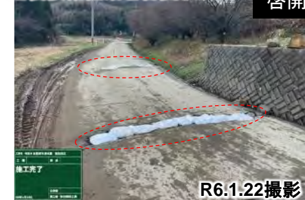
舗装損傷箇所を啓開状況
