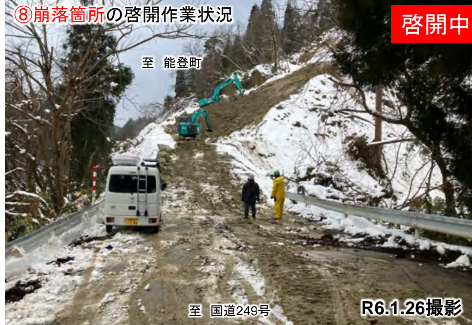
⑧崩落箇所の啓開作業状況
