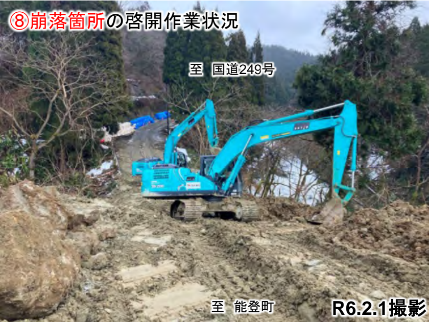
⑧崩落箇所の啓開作業状況
