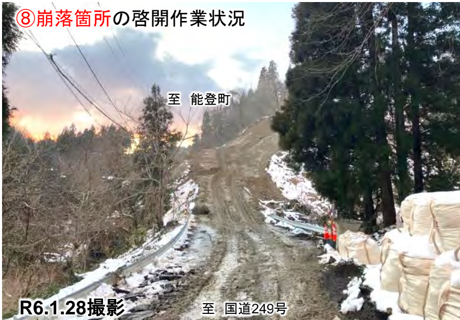
⑧崩落箇所の啓開作業状況
