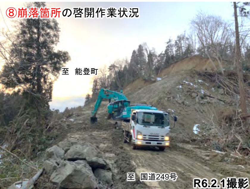
⑧崩落箇所の啓開作業状況
