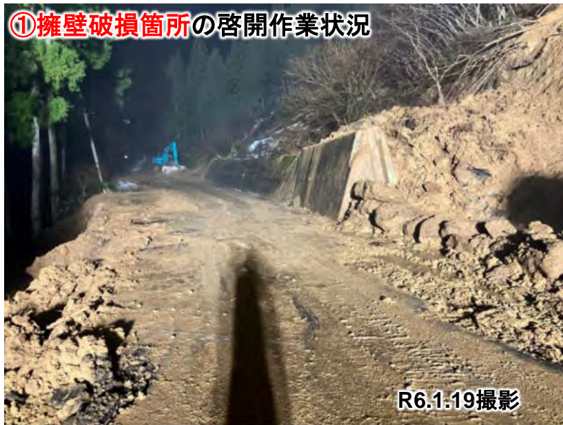
①擁壁破損箇所の啓開作業状況
