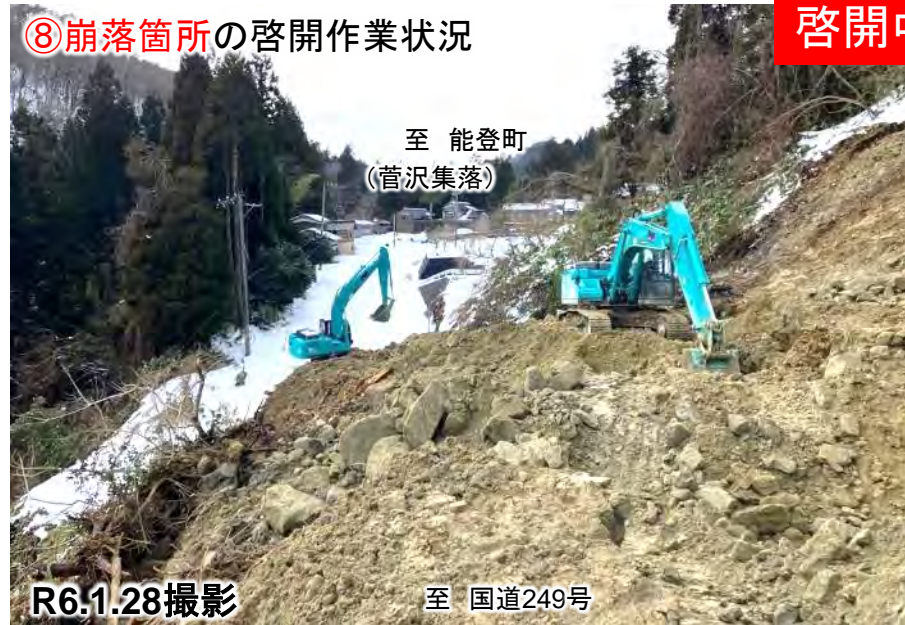
⑧崩落箇所の啓開作業状況
