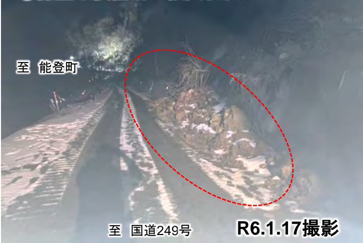
①擁壁破損箇所の啓開作業状況
