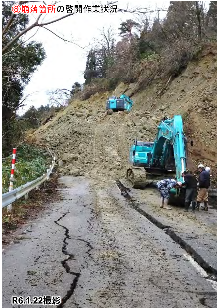
⑧崩落箇所の啓開作業状況
