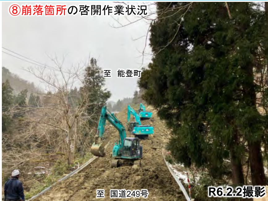
⑧崩落箇所の啓開作業状況
