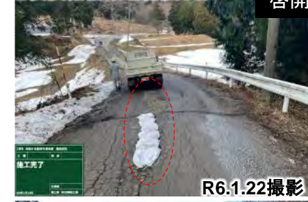
舗装損傷箇所を啓開状況
