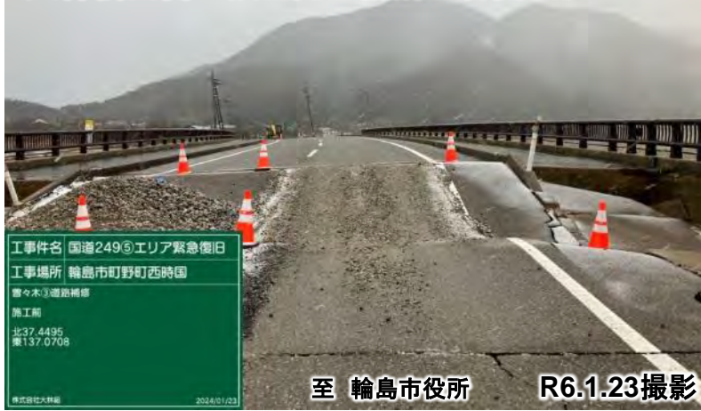
天神橋西側の段差発生箇所の啓開状況
