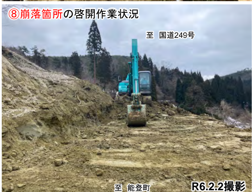
⑧崩落箇所の啓開作業状況
