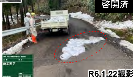
舗装損傷箇所を啓開状況
