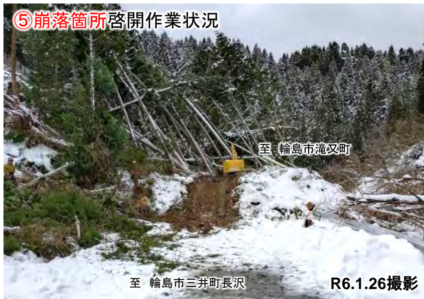
⑤崩落箇所啓開作業状況
