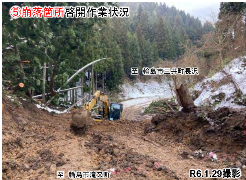
⑤崩落箇所啓開作業状況
