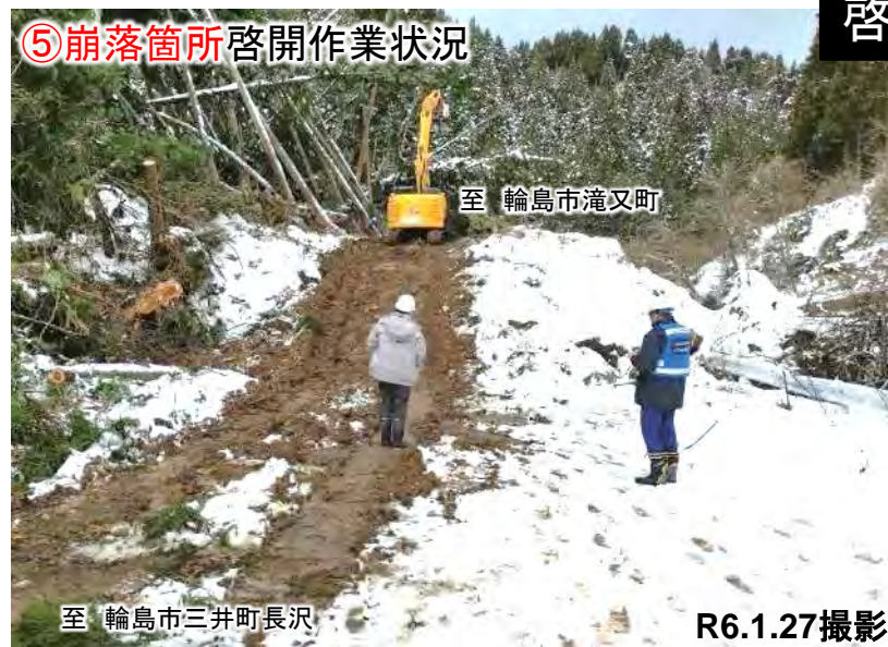
⑤崩落箇所啓開作業状況
