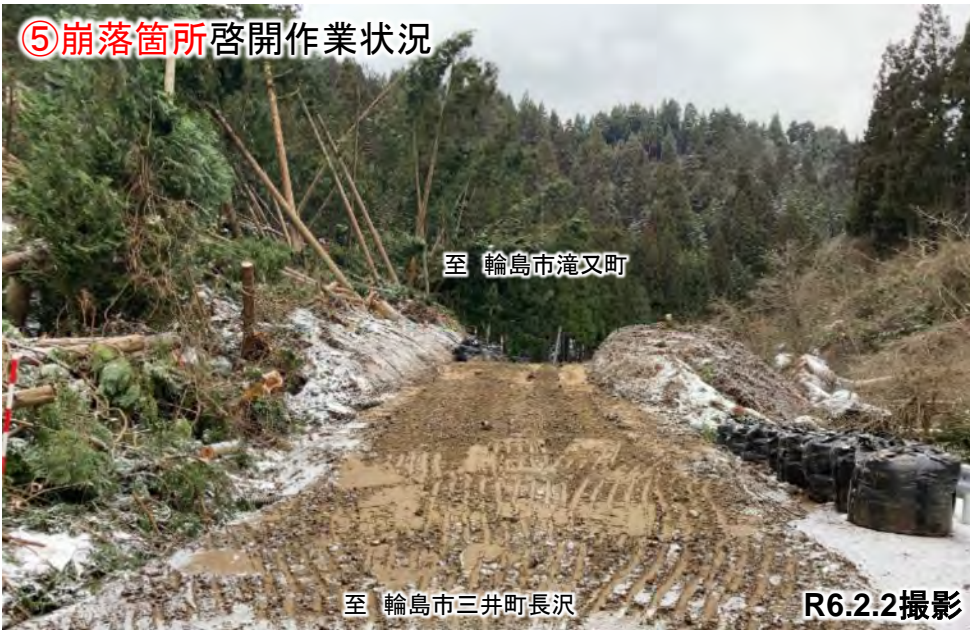
⑤崩落箇所啓開作業状況
