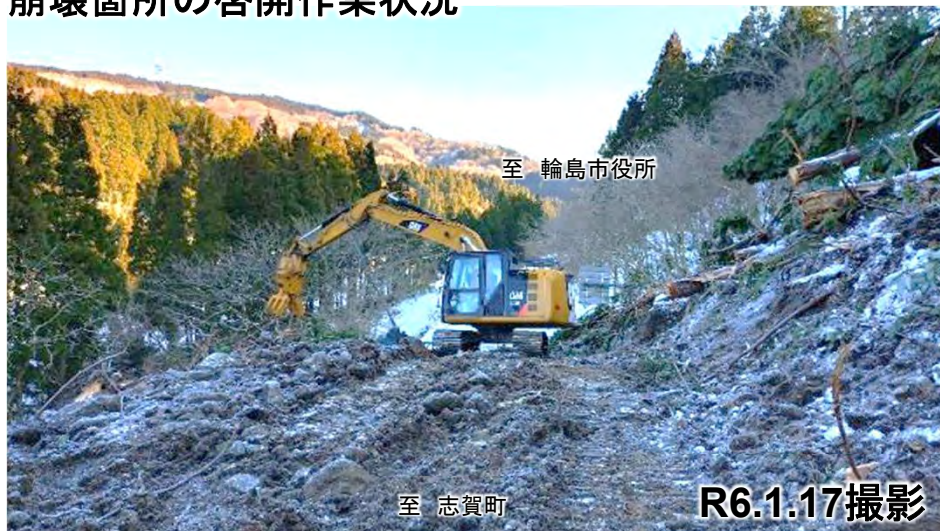
崩壊箇所の啓開作業状況
