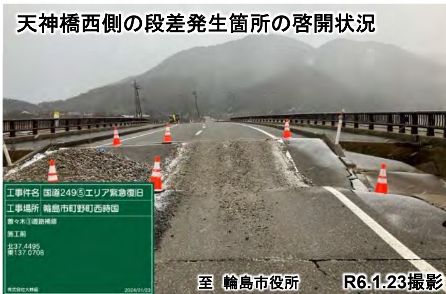
天神橋西側の段差発生箇所の啓開状況
