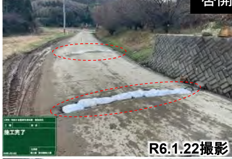
舗装損傷箇所を啓開状況
