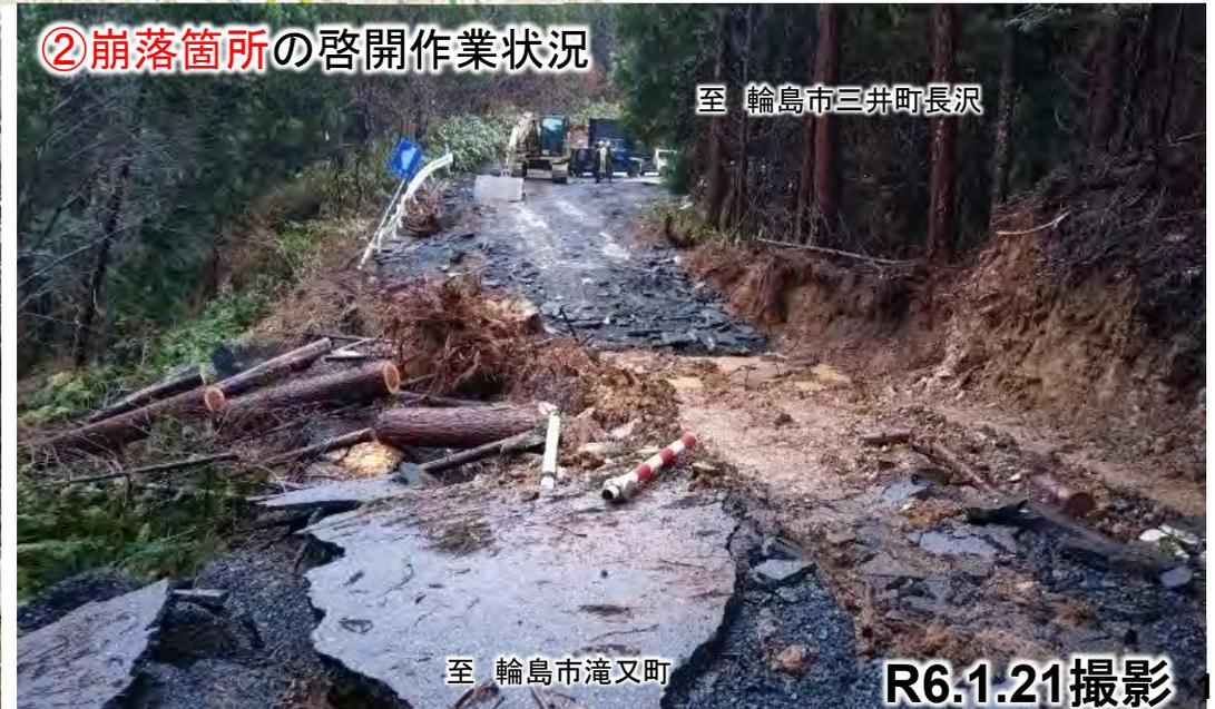
● 輪島市三井町長沢「県道1号線接続交差点」から1.9km地点 輪島市三井町長沢 崩落箇所の啓開作業状況
