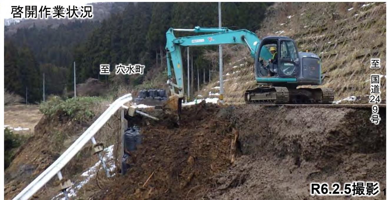
● 輪島市二俣町の国道249号「二俣町交差点」より 3.8km地点 輪島市滝又町付近 崩落箇所Aの啓開状況
