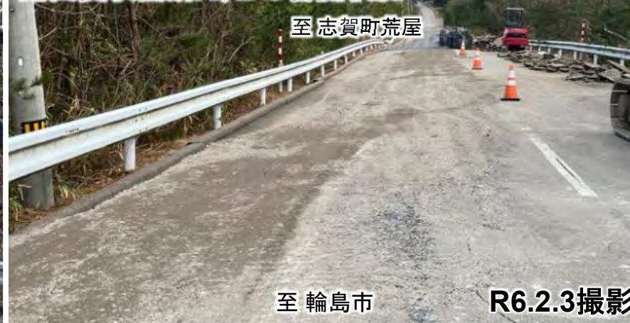
路面変状箇所A、Bの啓開状況
