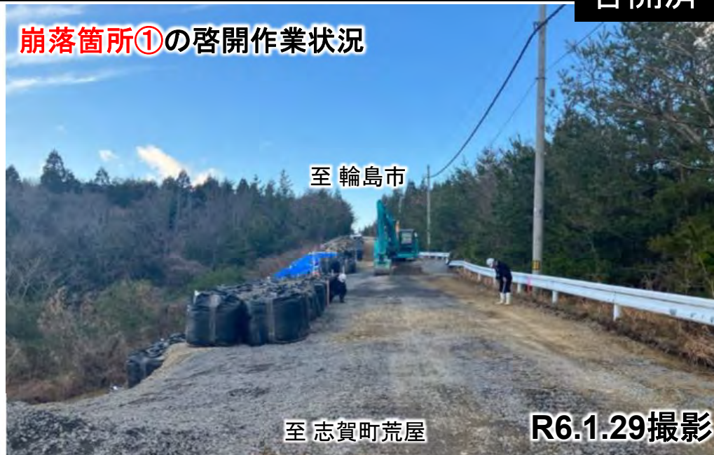
崩落箇所①の啓開作業状況
