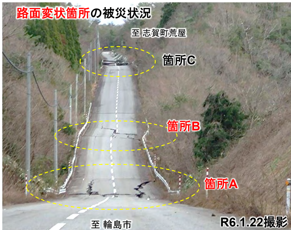
路面変状箇所A、Bの啓開状況
