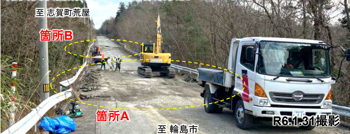
路面変状箇所A、Bの啓開作業状況
