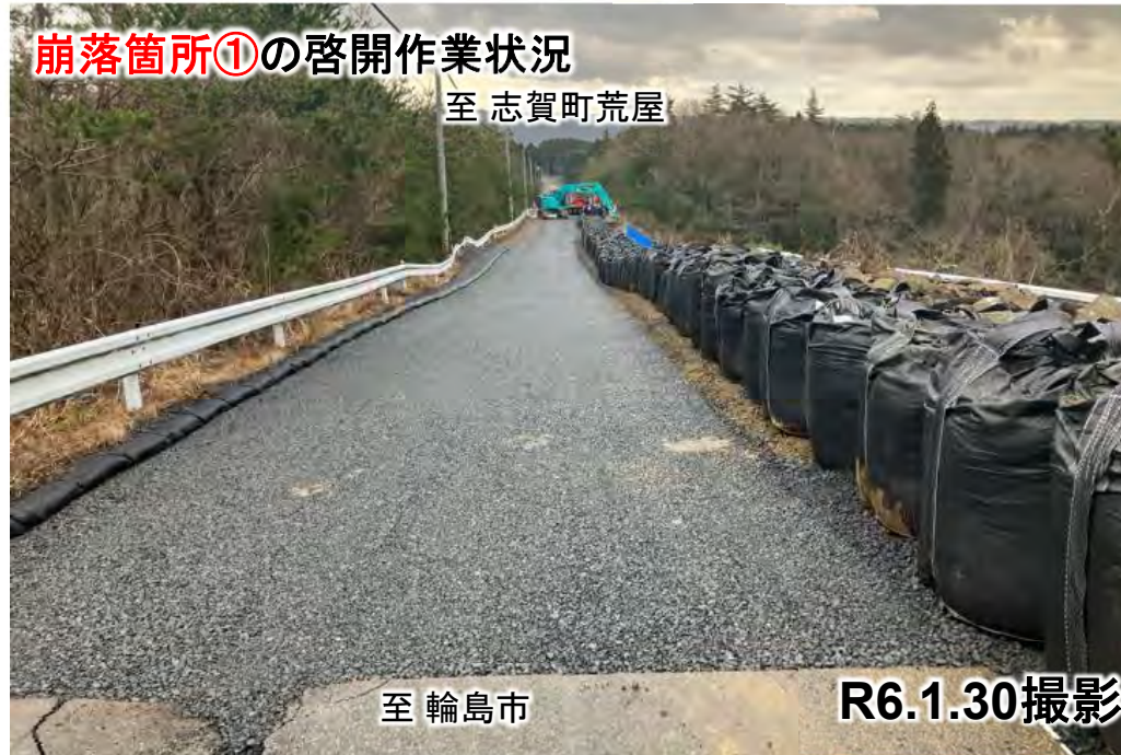
崩落箇所①の啓開作業状況
