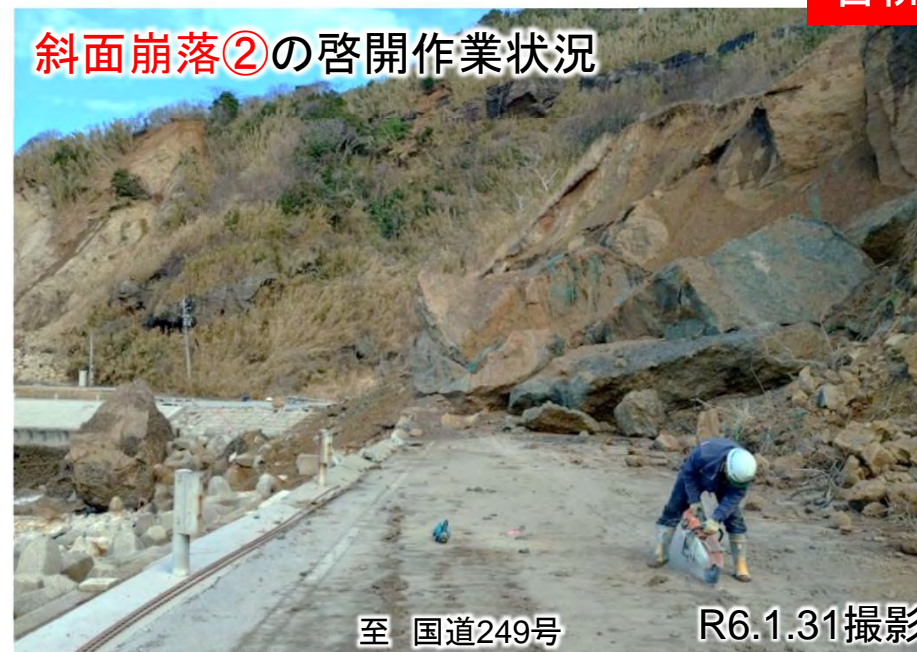
斜面崩落②の啓開作業状況
