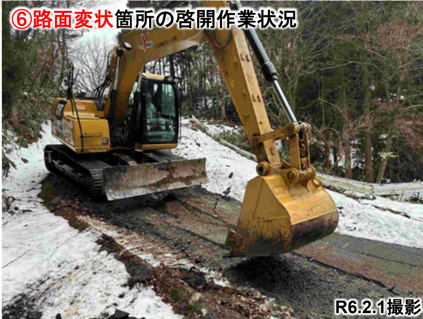
⑥路面変状箇所の啓開作業状況
