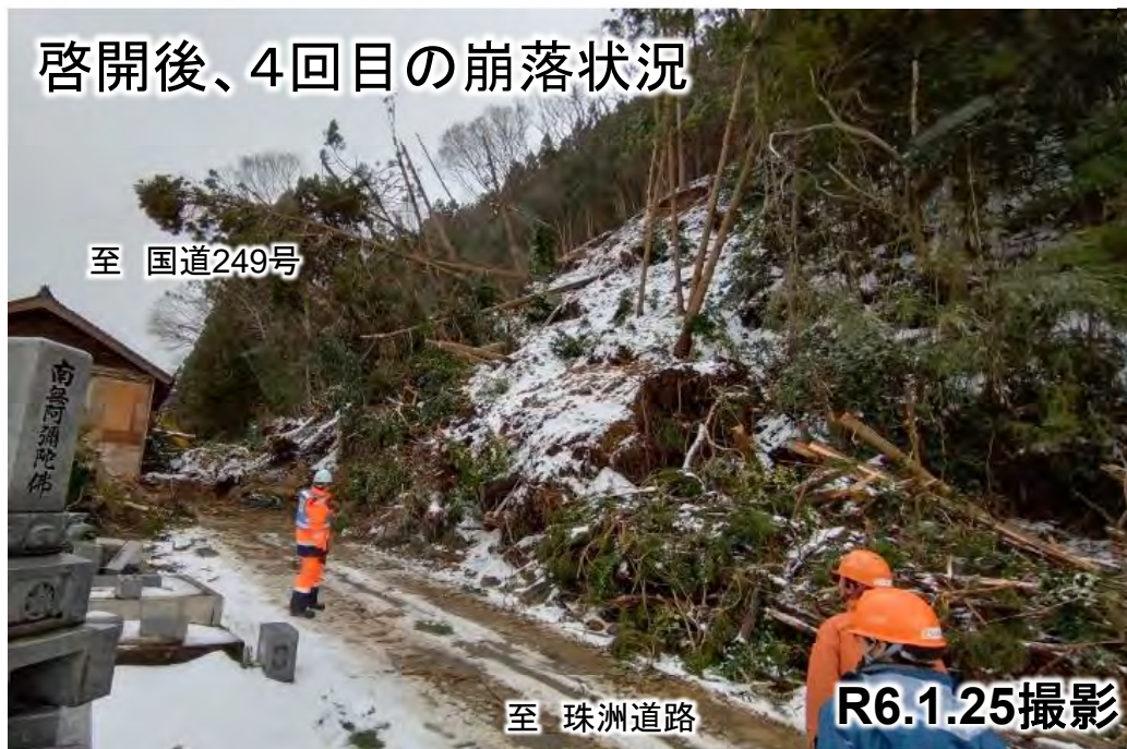
啓開後、4回目の崩落状況
