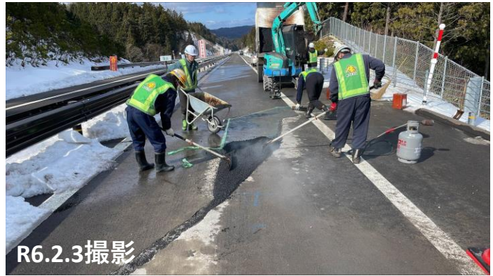
No.18 クラック・段差部補修状況
