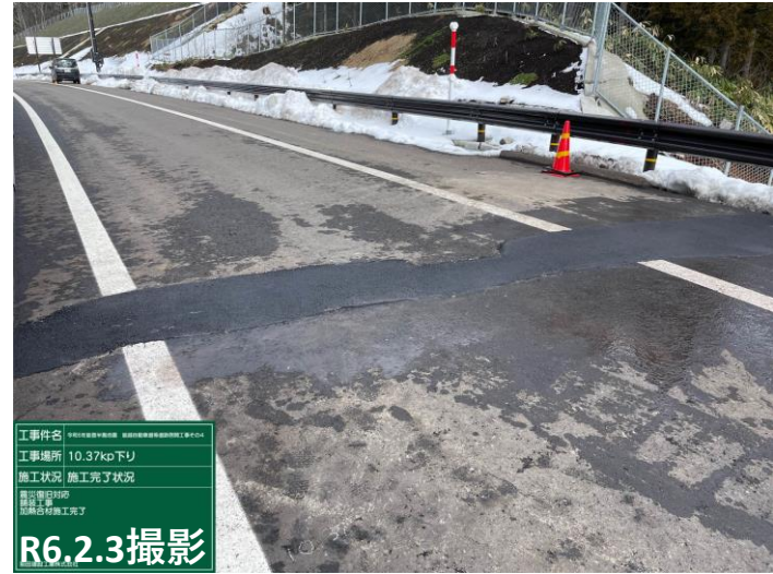
No.19 クラック補修完了
