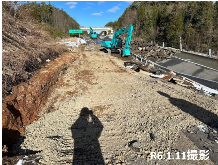
No.15 碎石充填状況
