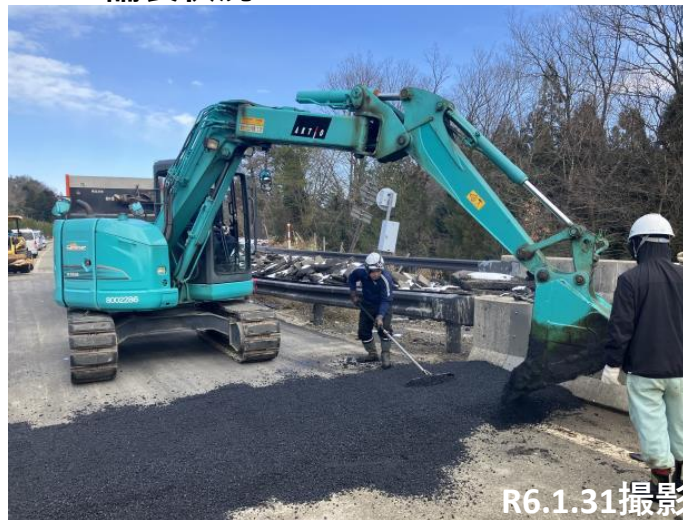
No32 舗装状況
