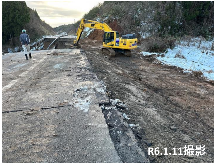
No.16 碎石充填状況
