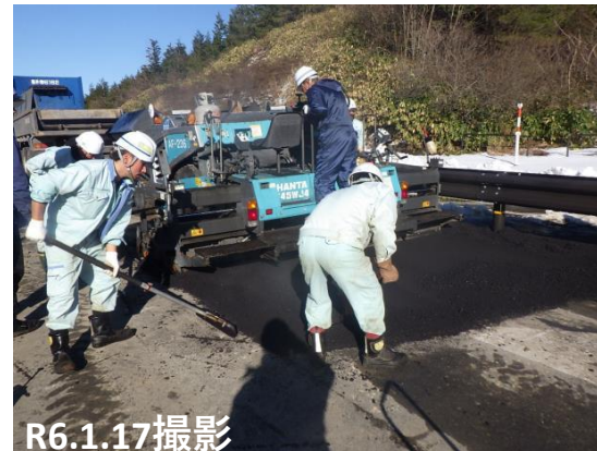
No.6 段差復旧状況
