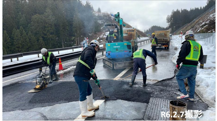
No.6付近 段差舗装完了
