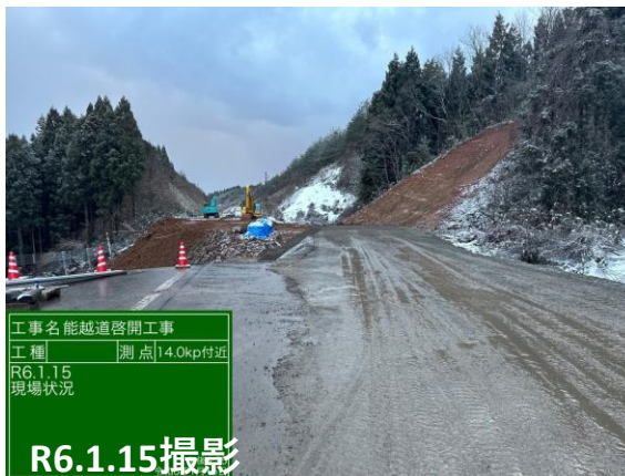
No.16 法面切土
