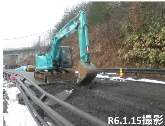
No.6段差復旧状況
