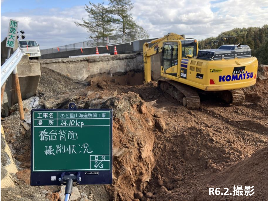
No. 50 橋台背面掘削状況
