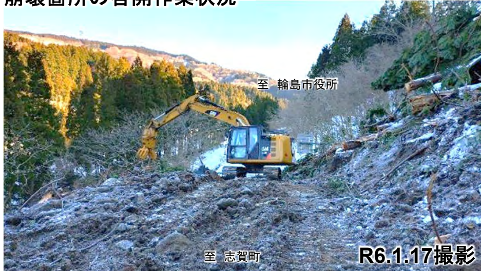
崩壊箇所の啓開作業状況
