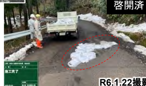
舗装損傷箇所を啓開状況
