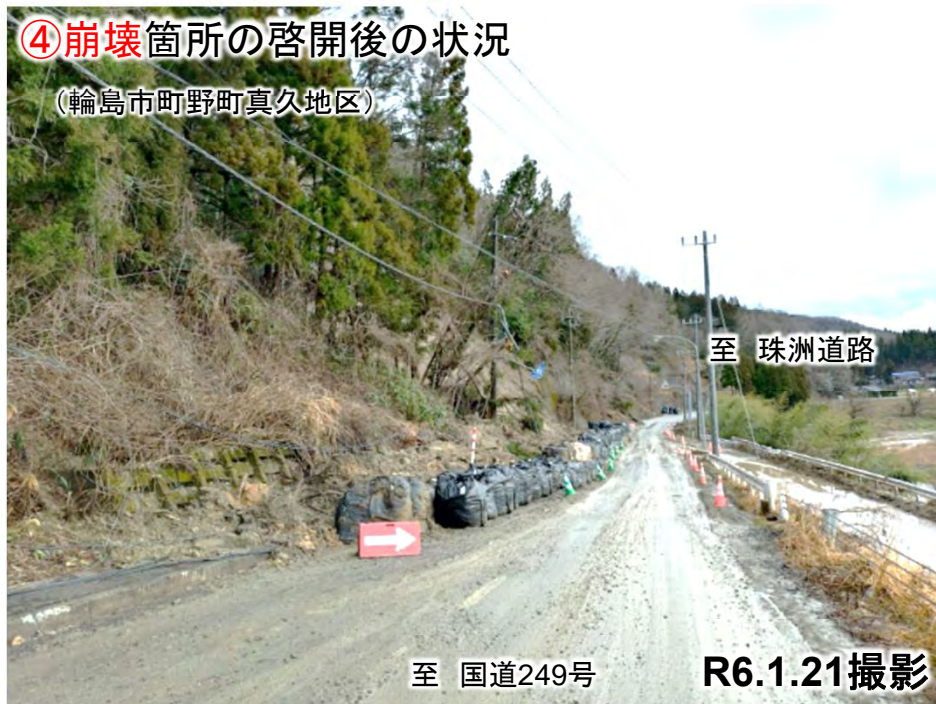
④崩壊箇所の啓開後の状況
