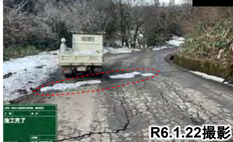
舗装損傷箇所を啓開状況
