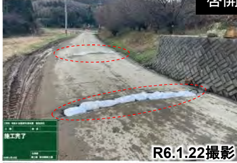
舗装損傷箇所を啓開状況
