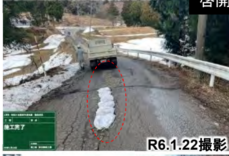
舗装損傷箇所を啓開状況
