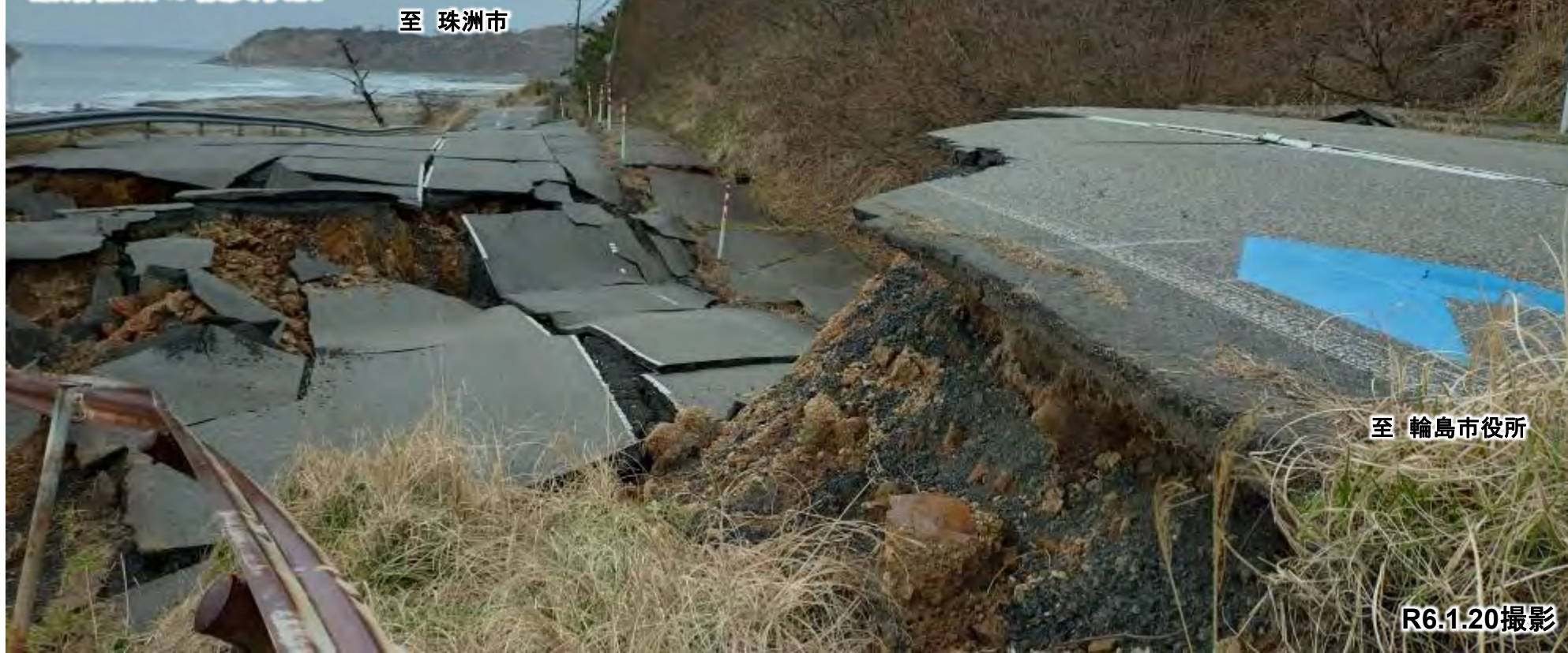
崩落箇所の被災状況
