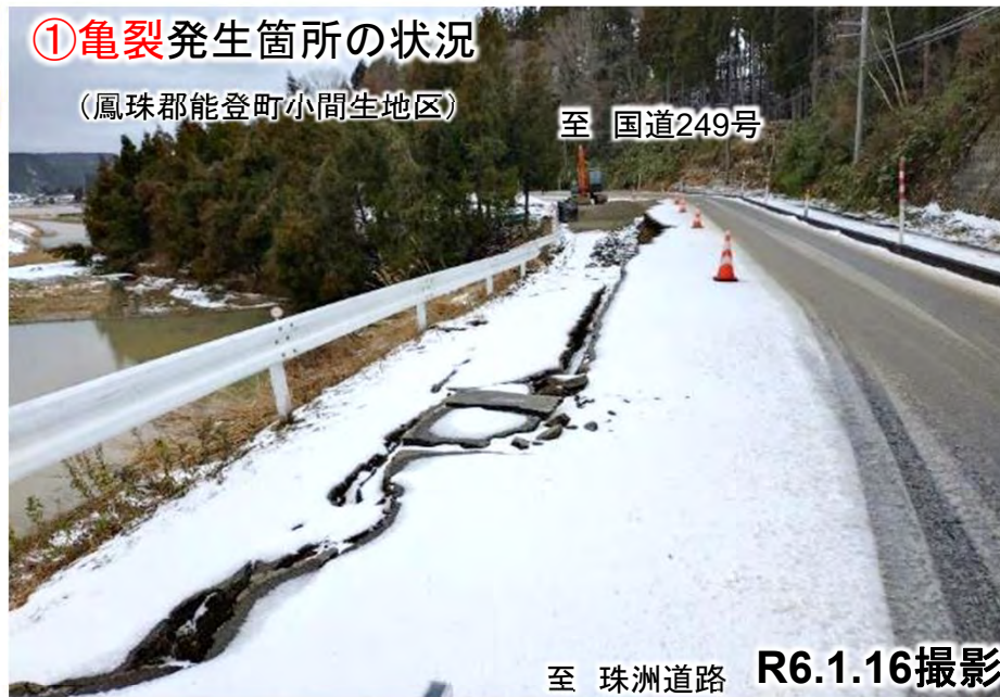
① 亀裂発生箇所の啓開後の状況
