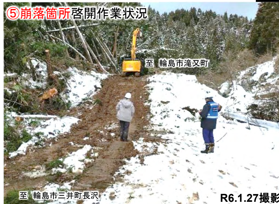
⑤崩落箇所啓開作業状況
