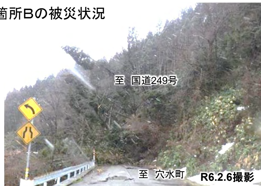
崩落箇所Bの被災状況
