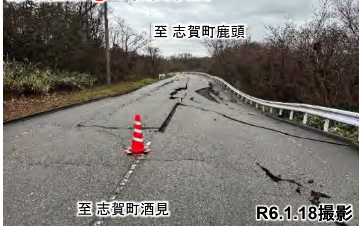
崩壊箇所①の被災状況
