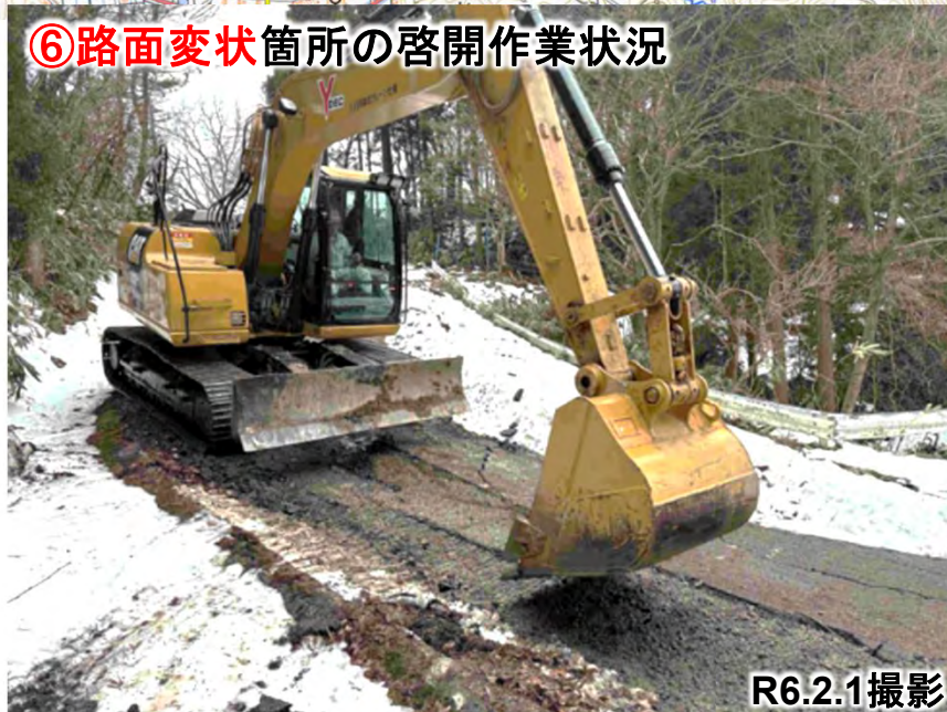
⑥路面変状箇所の啓開作業状況
