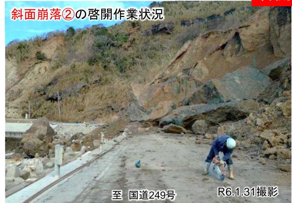
斜面崩落②の啓開作業状況
