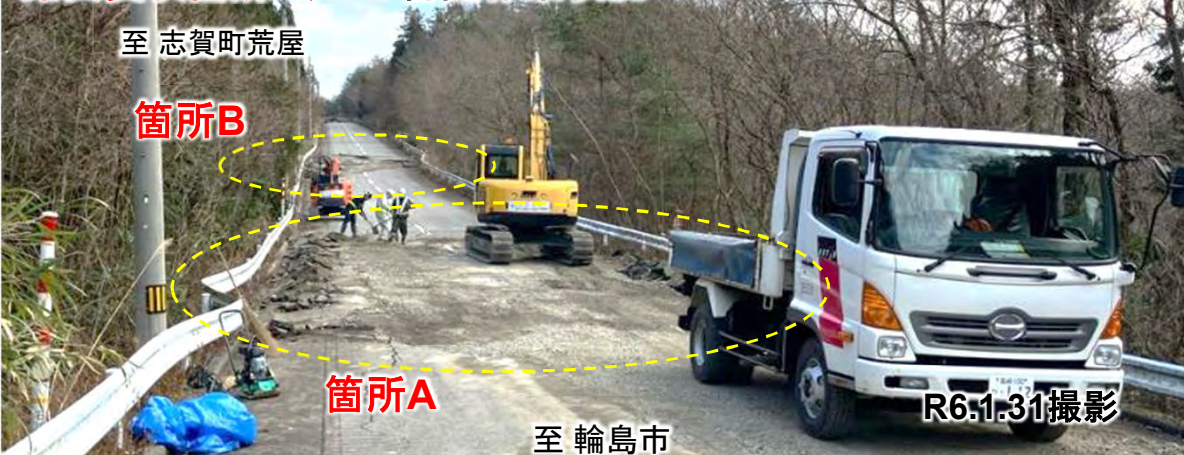
路面変状箇所A、Bの啓開作業状況
