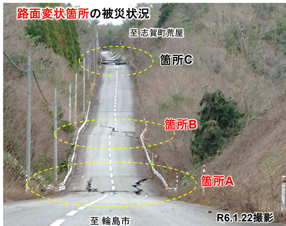
路面変状箇所A、Bの啓開状況
