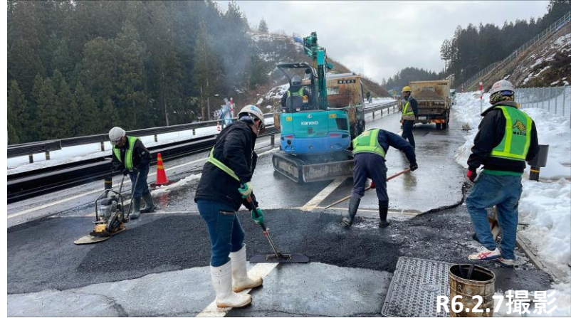
No.6付近 段差舗装完了
