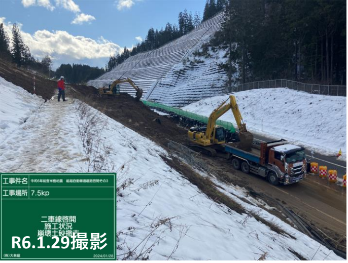
No.3 土砂掘削及び積込状況
