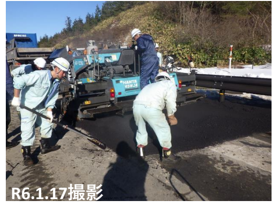
No.6 段差復旧状況
