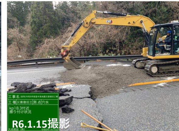
No.56 段差擦り付け
