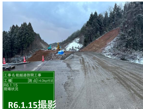
No.16 法面切土
