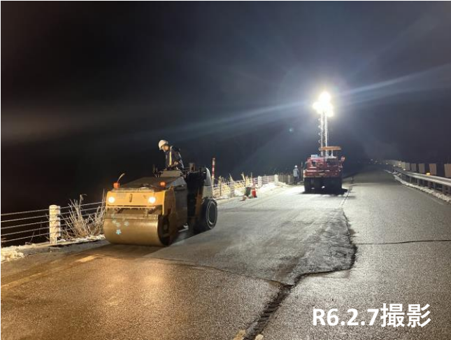
No.34付近 舗装状況
