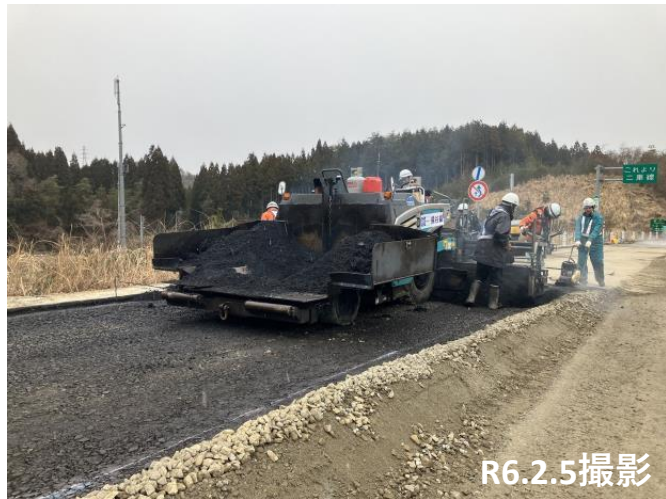
No.29～30付近 舗装施工状況
