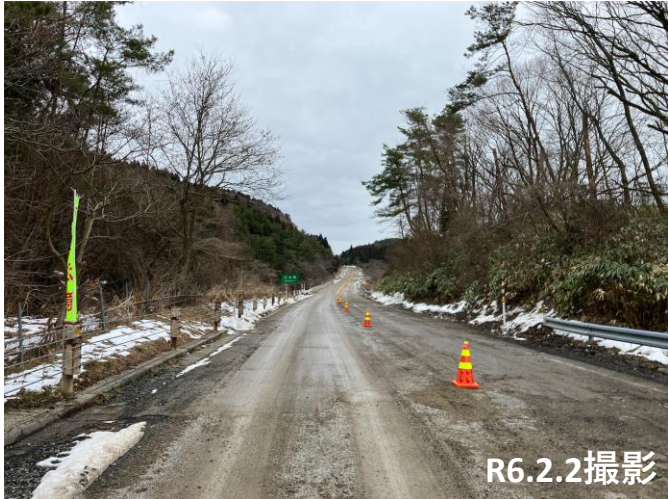
No.7付近 路盤施工状況
