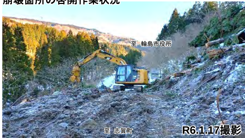
崩壊箇所の啓開作業状況
