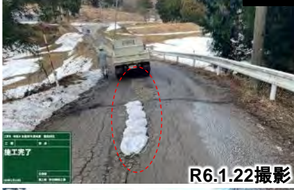
舗装損傷箇所を啓開状況
