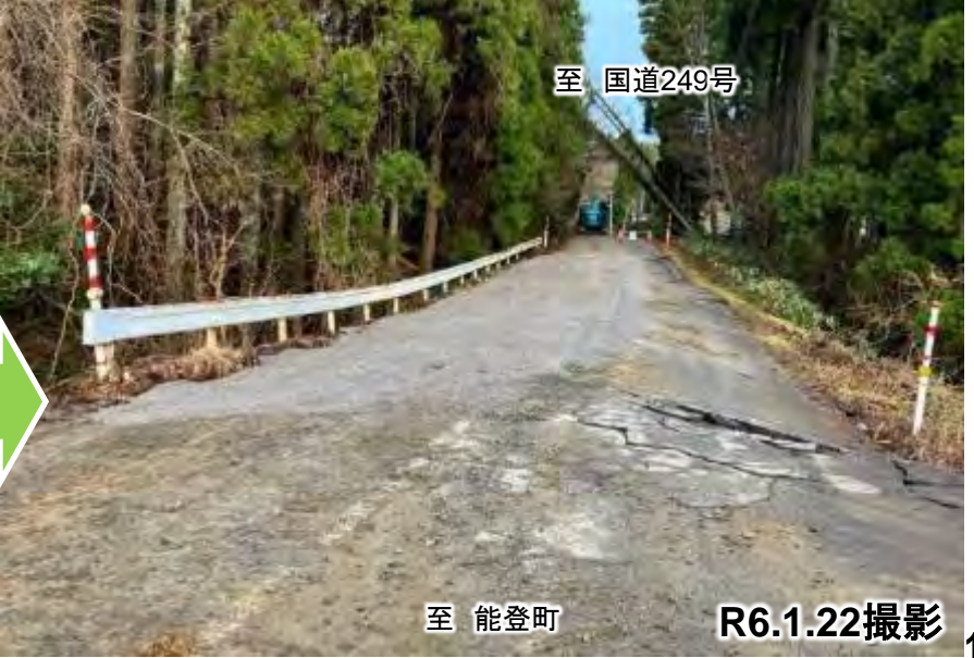
⑦路面変状箇所の啓開作業状況
