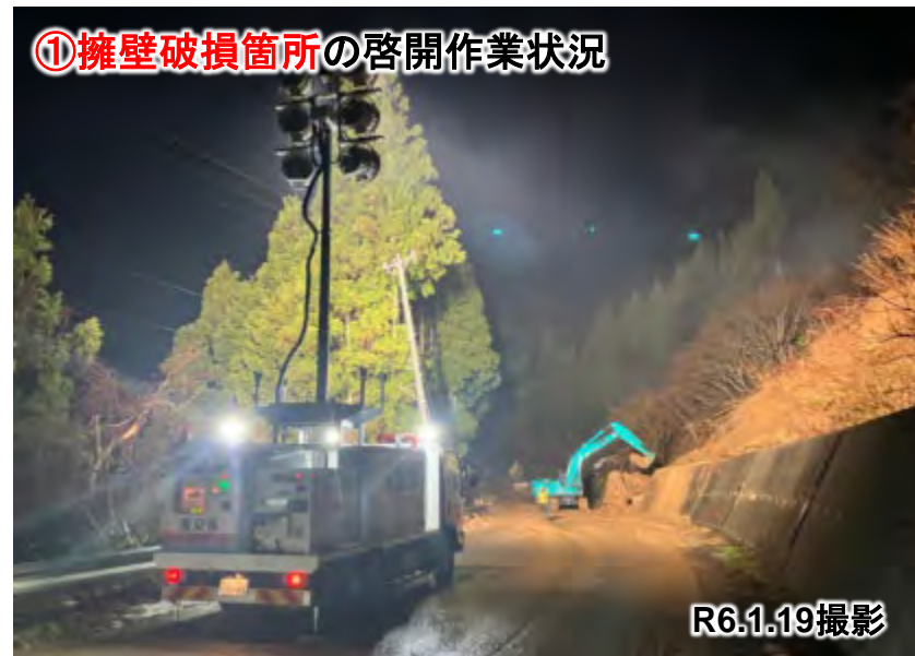
①擁壁破損箇所の啓開作業状況
