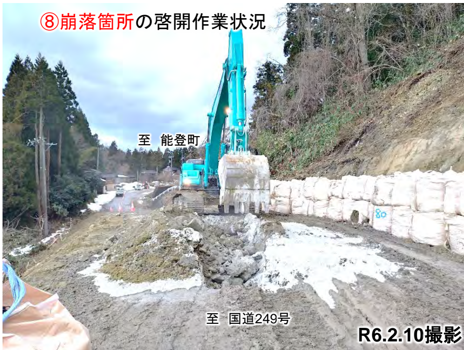
⑧崩落箇所の啓開作業状況
