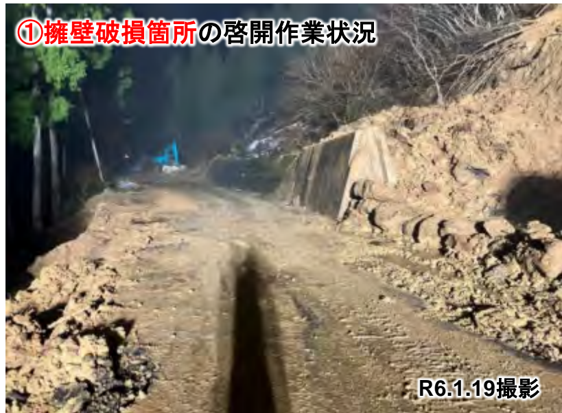
①擁壁破損箇所の啓開作業状況
