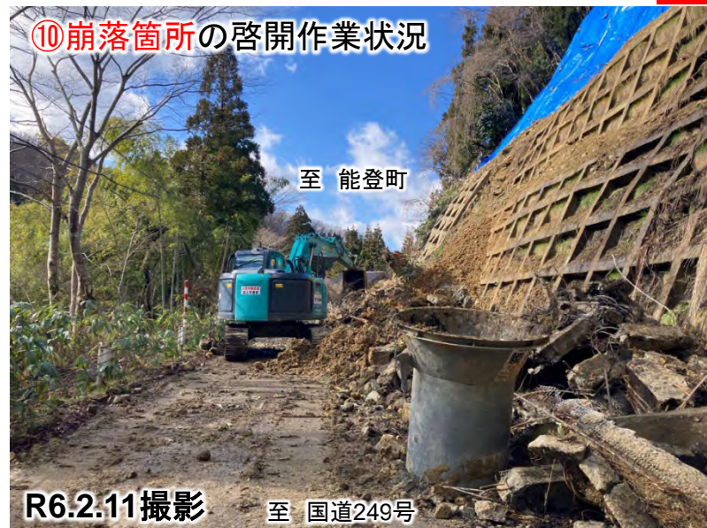
⑩崩落箇所の啓開作業状況
