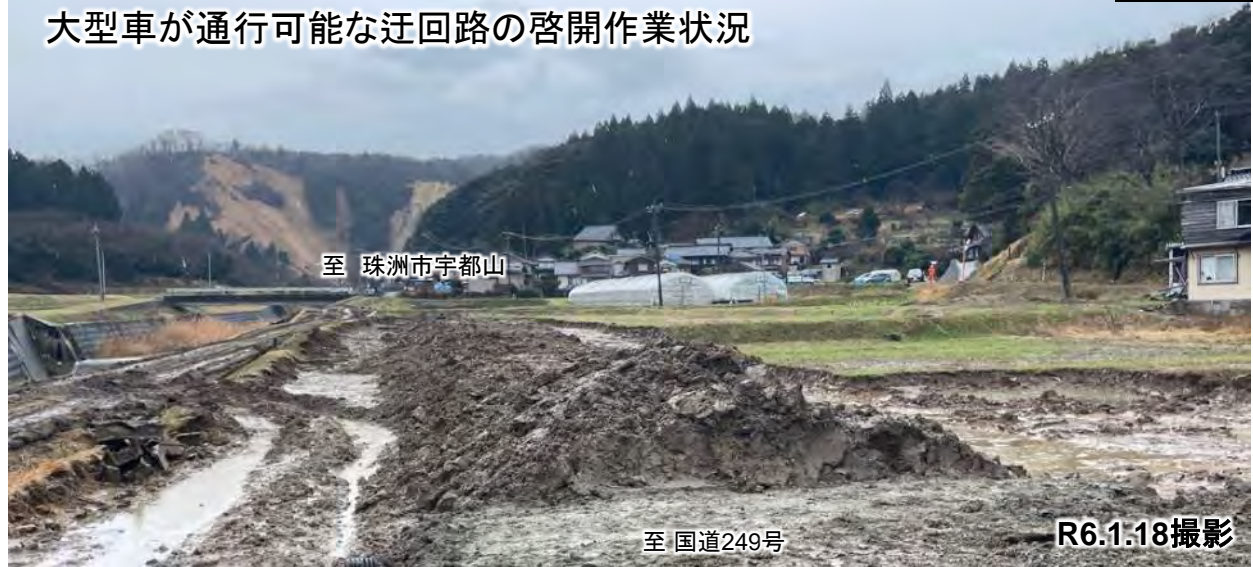
大型車が通行可能な迂回路を啓開作業状況
