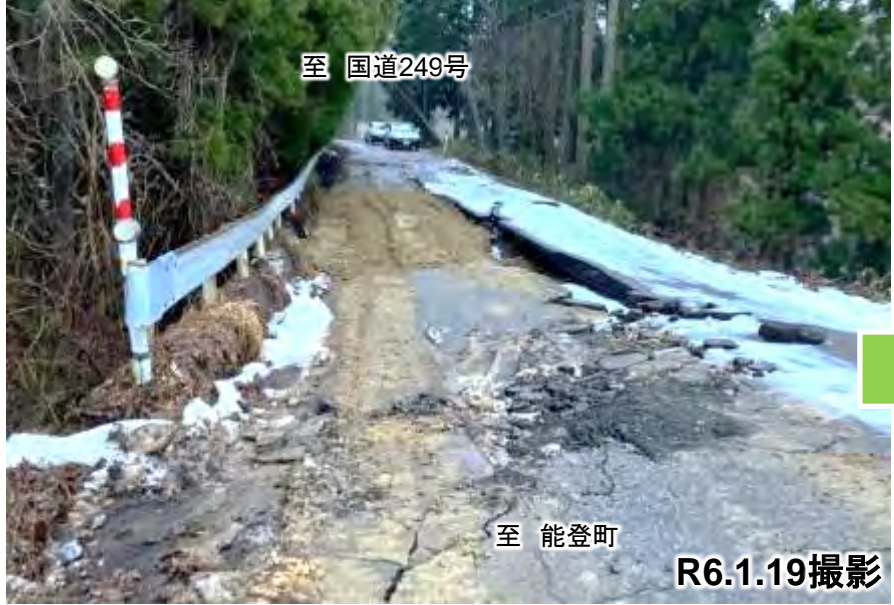
⑦路面変状箇所の被災状況
