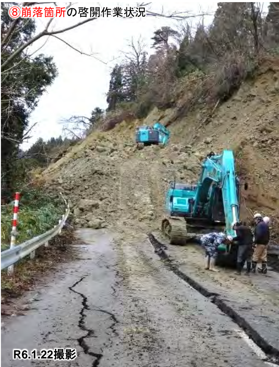
⑧崩落箇所の啓開作業状況
