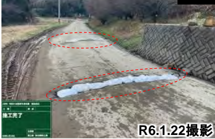
舗装損傷箇所を啓開状況
