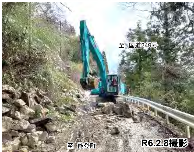
⑨崩落箇所啓開作業状況
