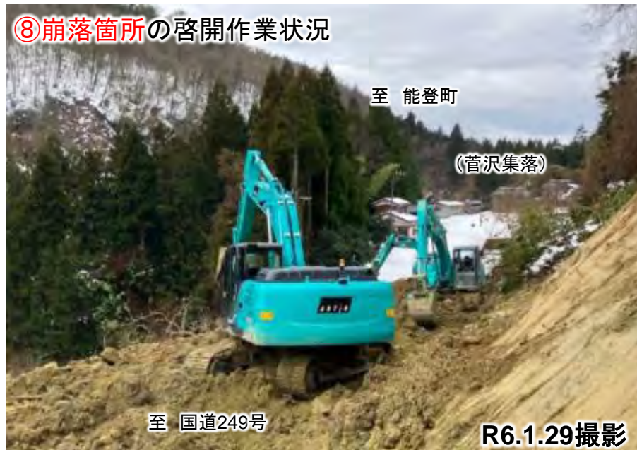
⑧崩落箇所の啓開作業状況
