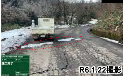
舗装損傷箇所を啓開状況
