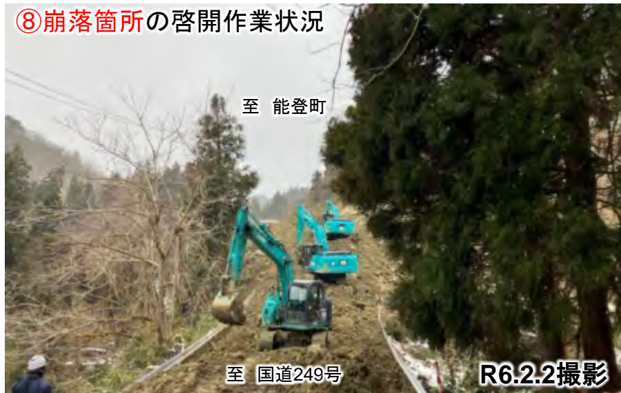
⑧崩落箇所の啓開作業状況
