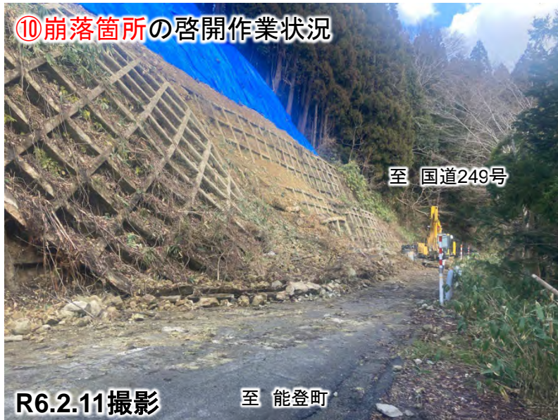
⑩崩落箇所の啓開作業状況
