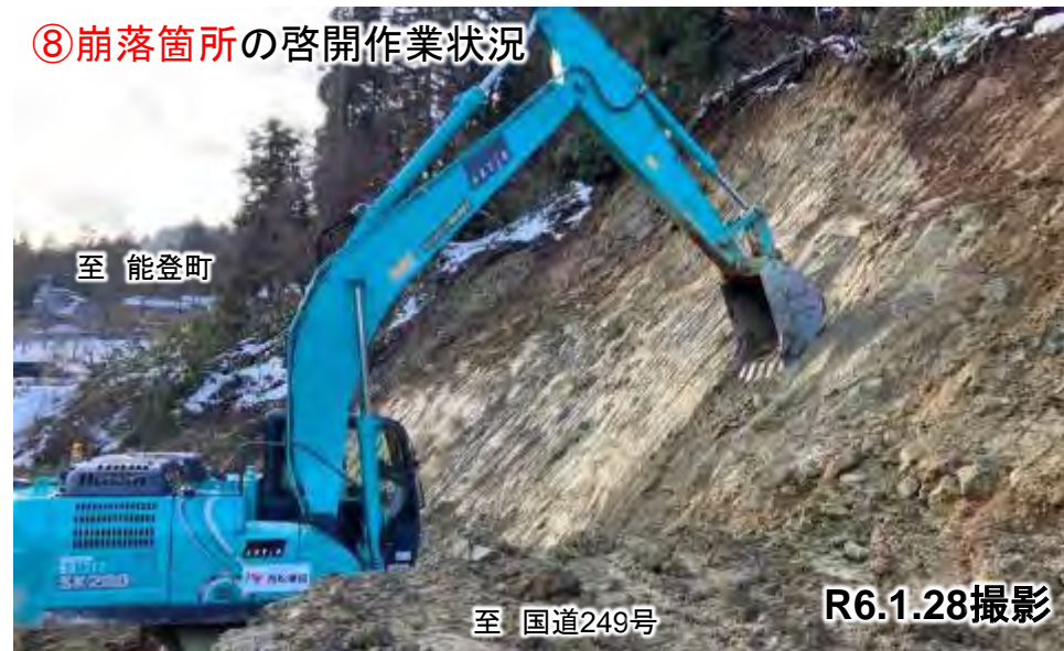
⑧崩落箇所の啓開作業状況
