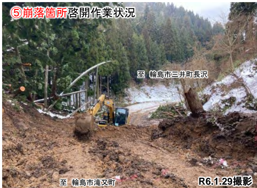
⑤崩落箇所啓開作業状況
