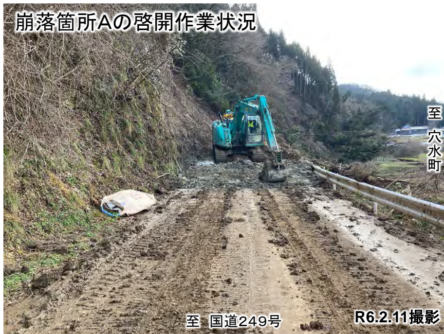
崩落箇所Aの啓開作業状況
