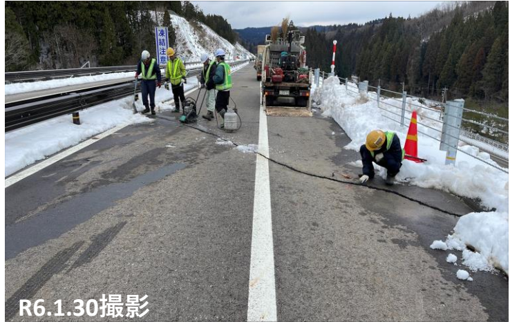
No.18 クラック補修状況
