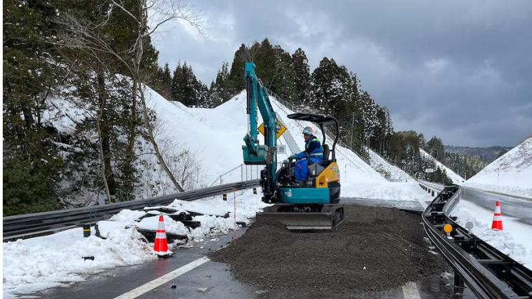
No.7 路面補修状況
