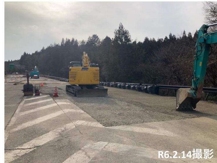
No.56 舗装撤去・砕石埋戻し
