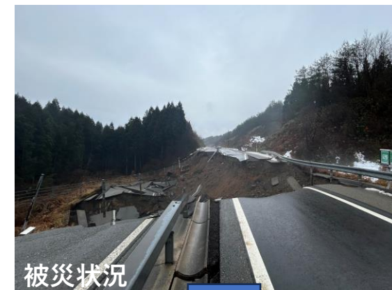
No16付近 1車線復旧完了
