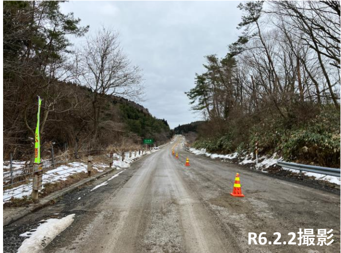
No.7付近 路盤施工状況
