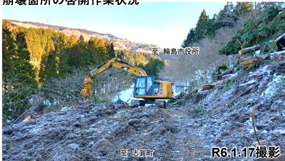
崩壊箇所の啓開作業状況
