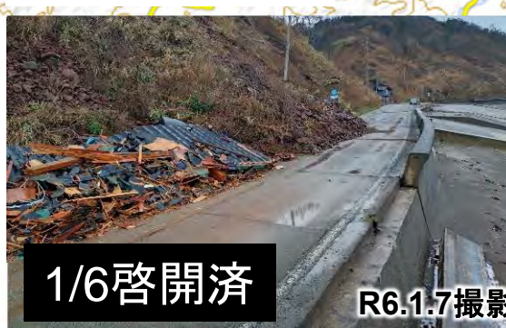
崩落箇所 啓開完了
