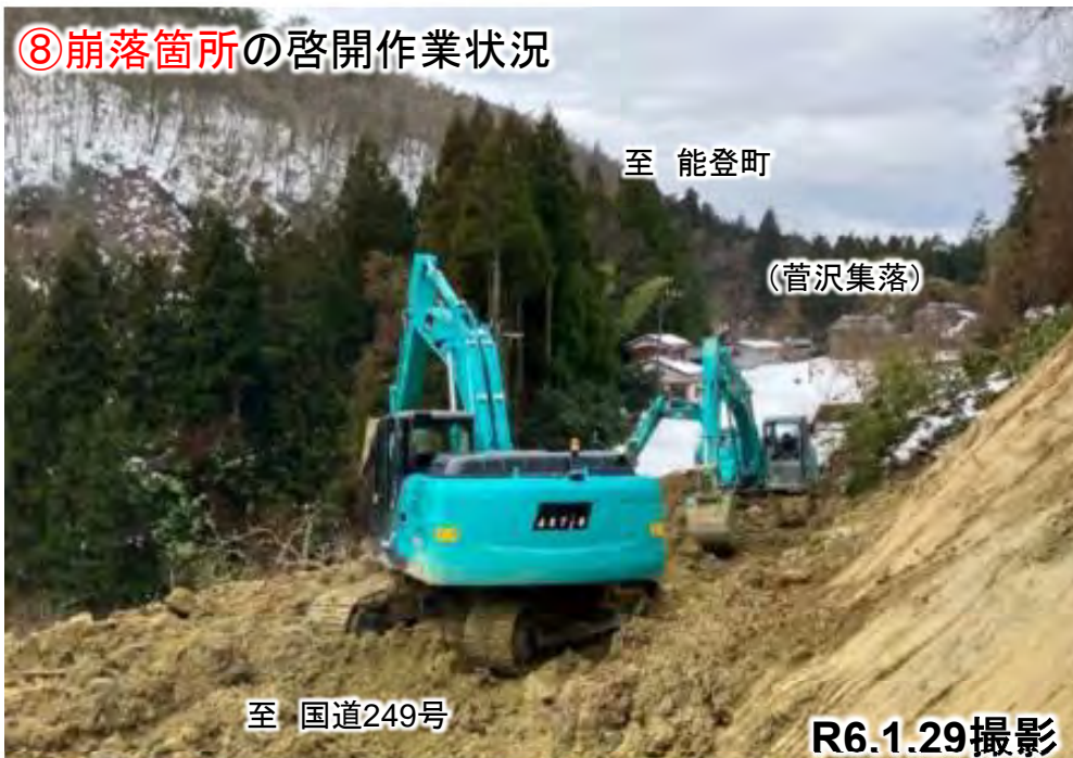
⑧崩落箇所の啓開作業状況
