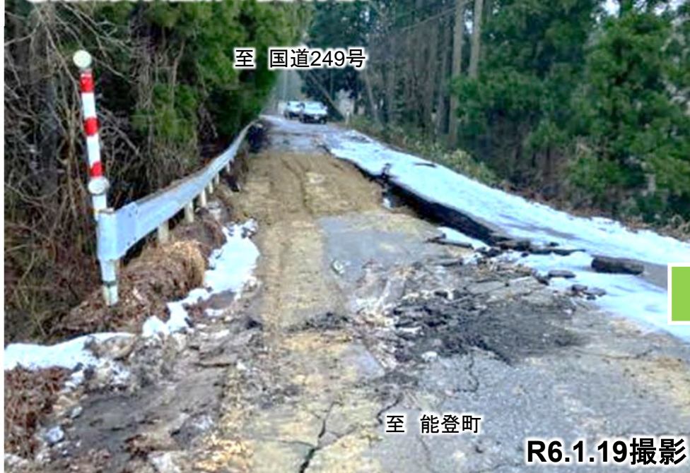
⑦路面変状箇所の被災状況
