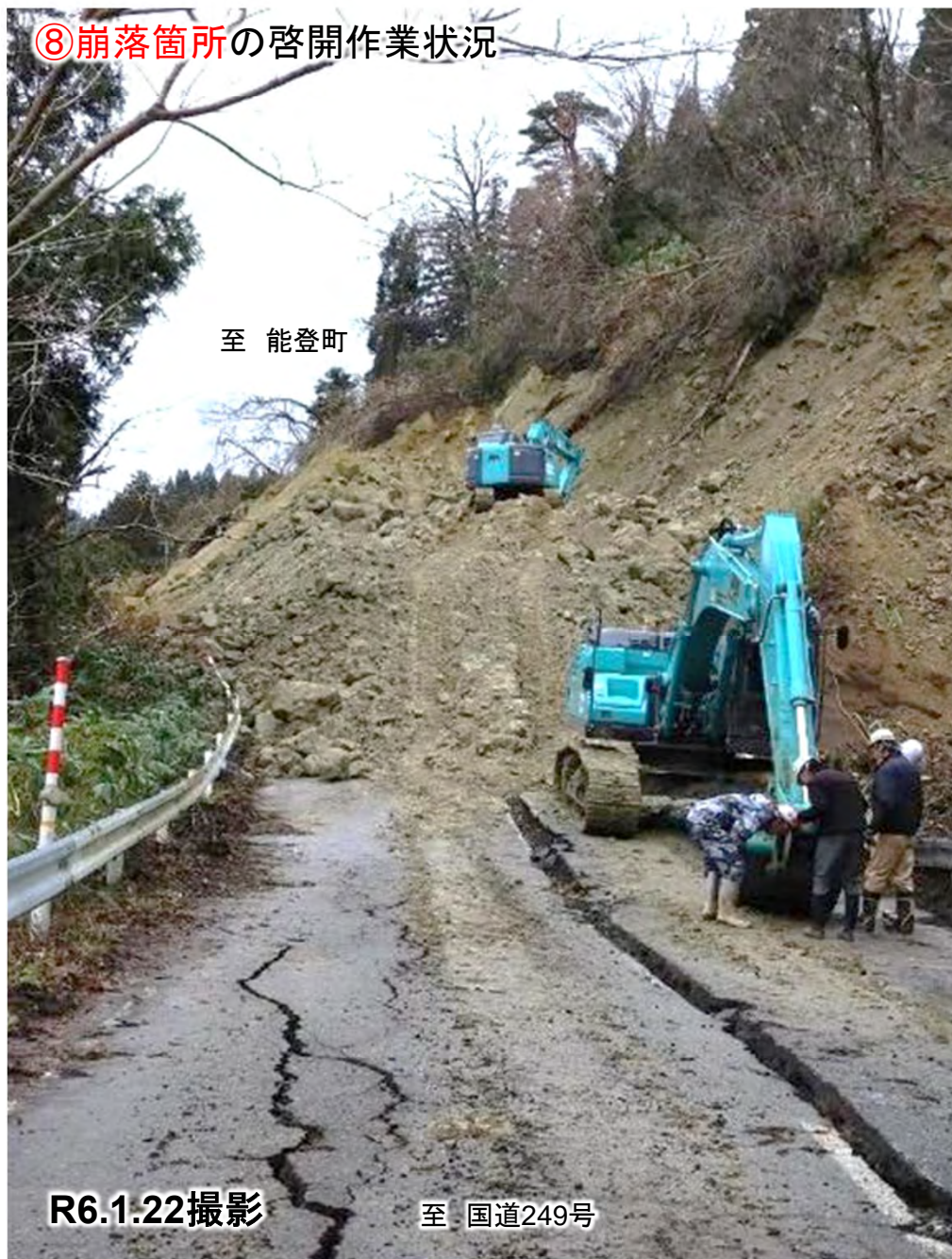
⑧崩落箇所の啓開作業状況
