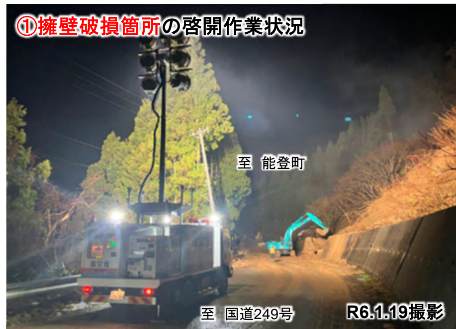
①擁壁破損箇所の啓開作業状況
