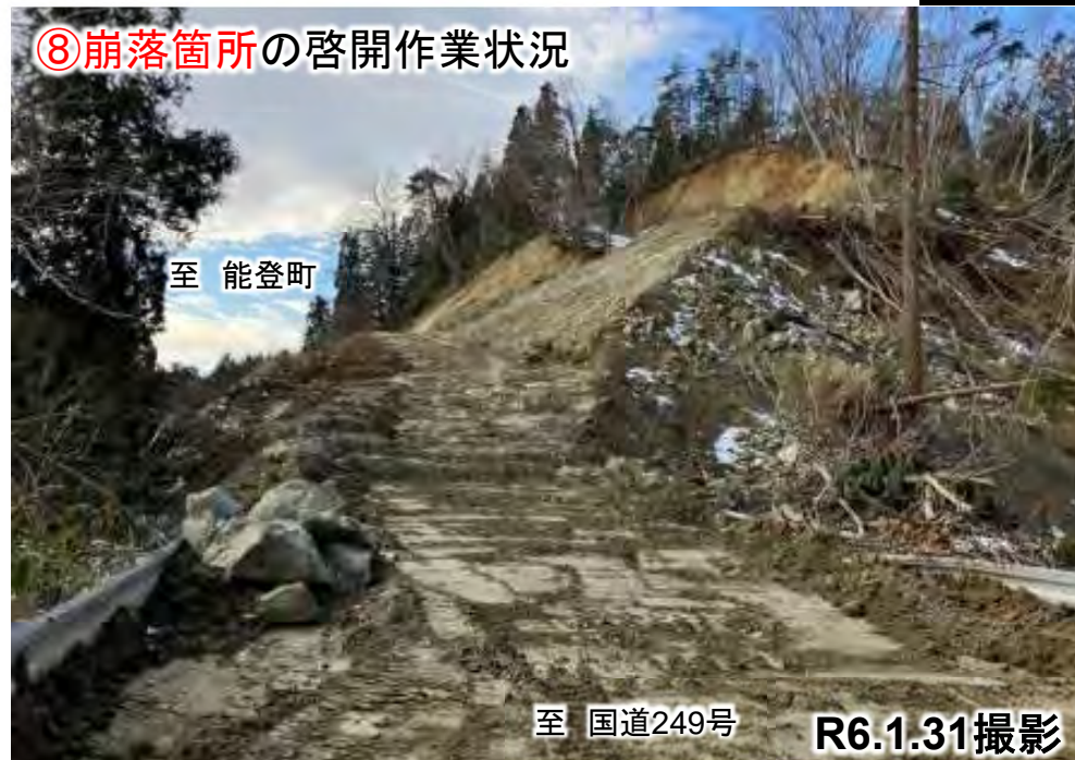
⑧崩落箇所の啓開作業状況
