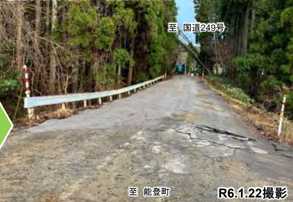
⑦路面変状箇所の啓開作業状況
