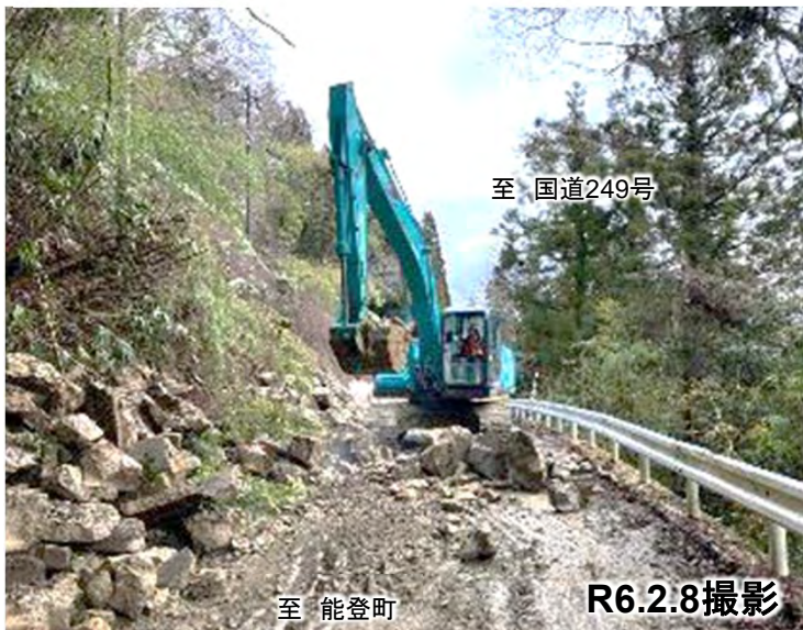
⑨崩落箇所啓開作業状況
