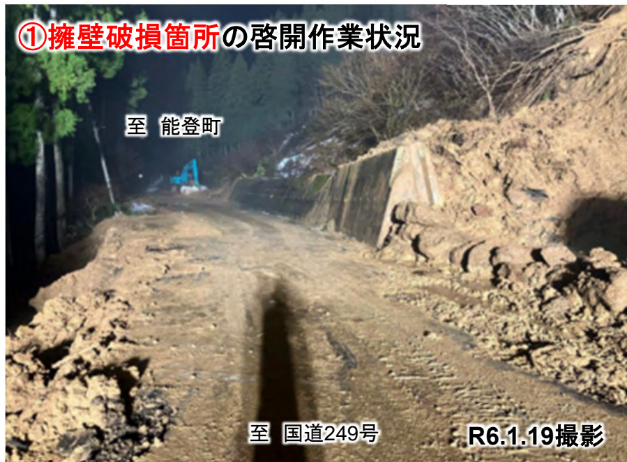
①擁壁破損箇所の啓開作業状況
