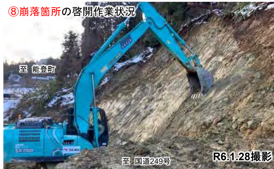
⑧崩落箇所の啓開作業状況
