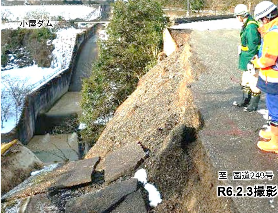
⑪崩落箇所被災状況
