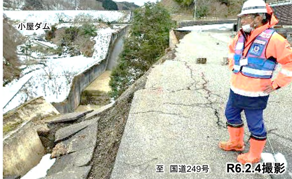
⑪崩落箇所被災状況
