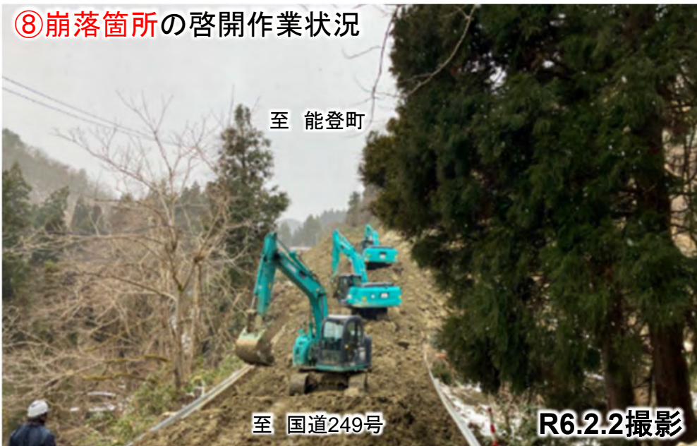
⑧崩落箇所の啓開作業状況
