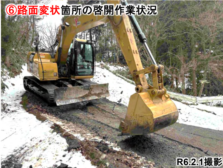
⑥路面変状箇所の啓開作業状況
