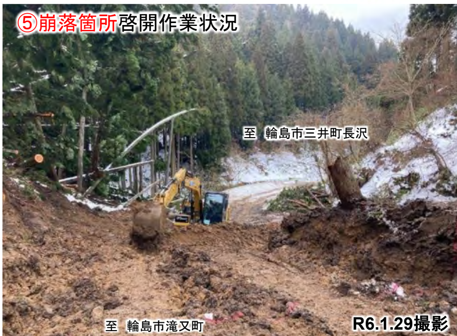
⑤崩落箇所啓開作業状況
