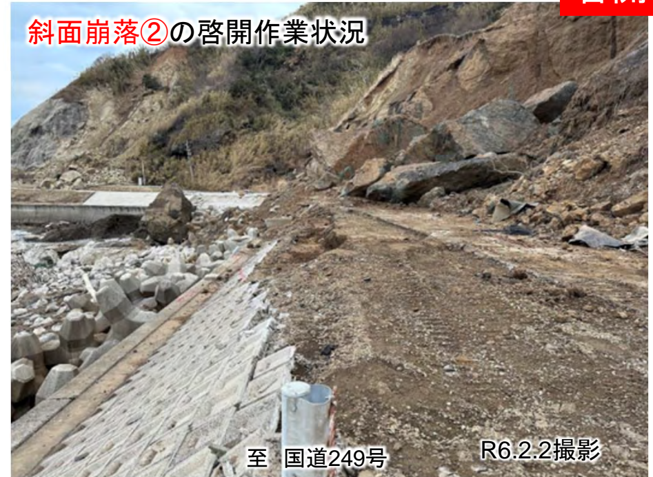
斜面崩落②の啓開作業状況
