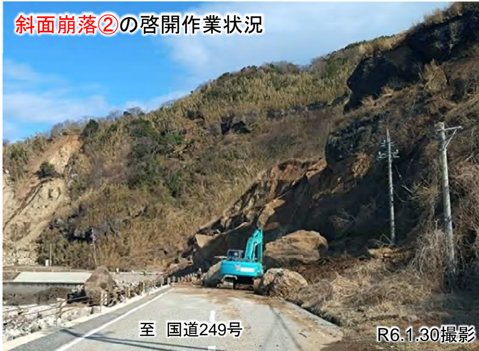
斜面崩落②の啓開作業状況
