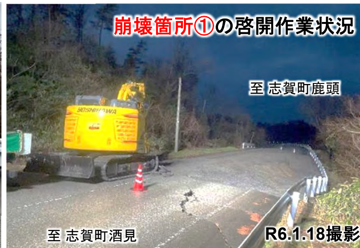
啓開作業状況
