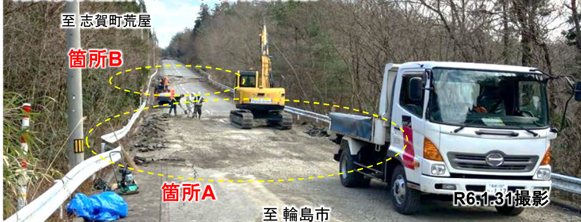
路面変状箇所A、Bの啓開作業状況
