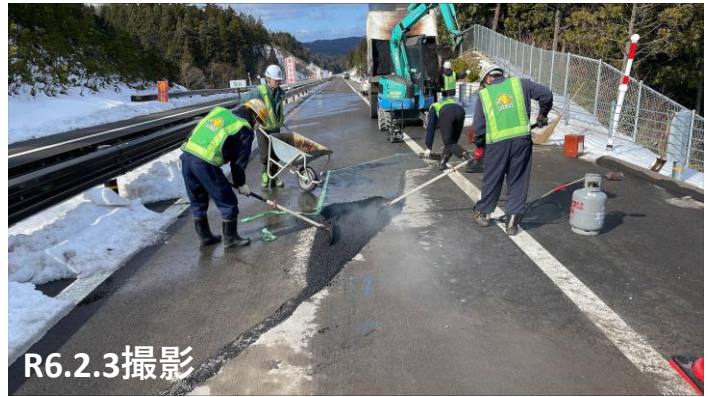
No.18 クラック・段差部補修状況
