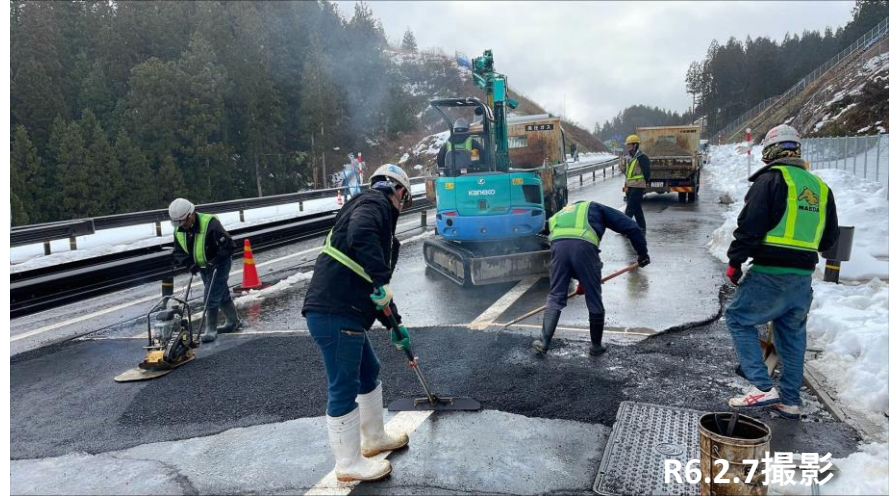
No.6付近 段差舗装完了
