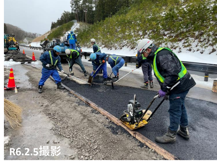
No.18 クラック・段差補修完了
