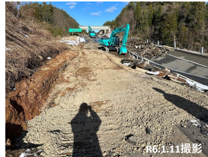
No.15 砕石充填状況
