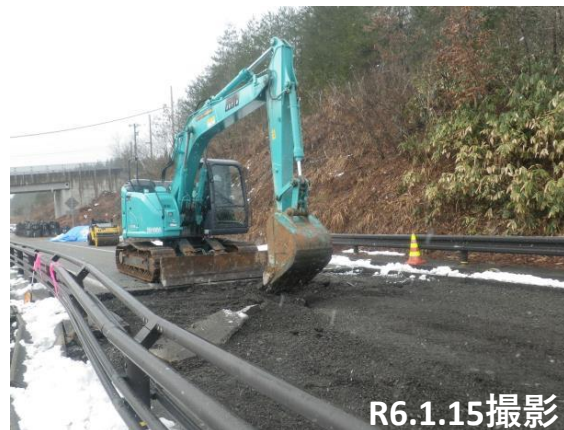
No.6段差復旧状況
