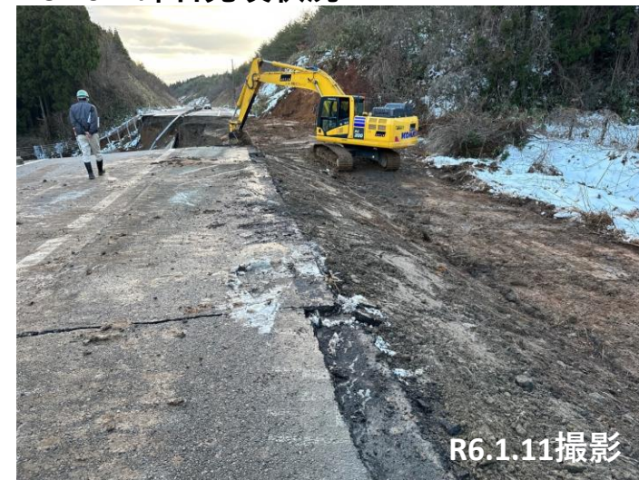
No.16 砕石充填状況
