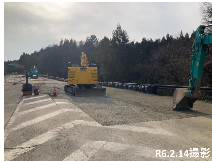
No.56 舗装撤去・砕石埋戻し
