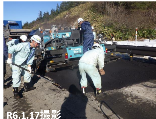
No.6 段差復旧状況
