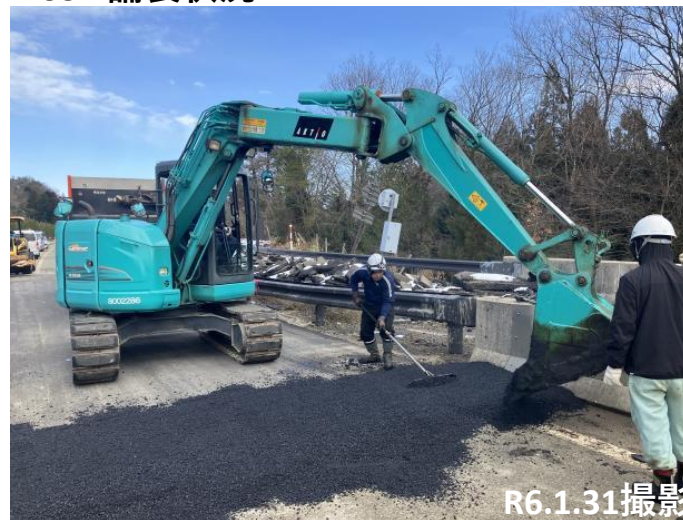
No32 舗装状況
