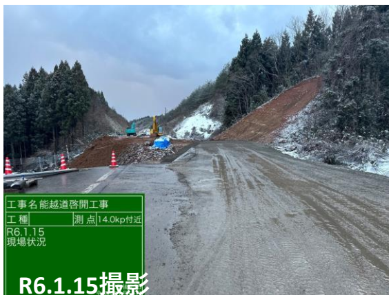
No.16 法面切土
