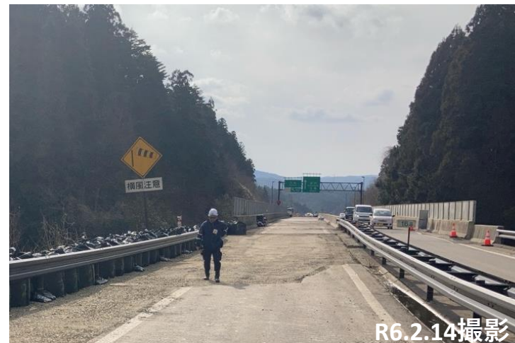
No.40 砕石敷均し状況
