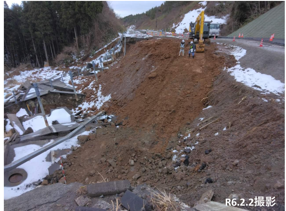
No.16 調査・整地状況
