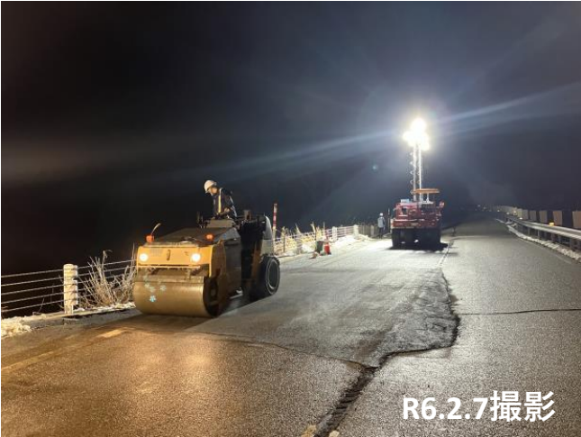
No.34付近 舗装状況
