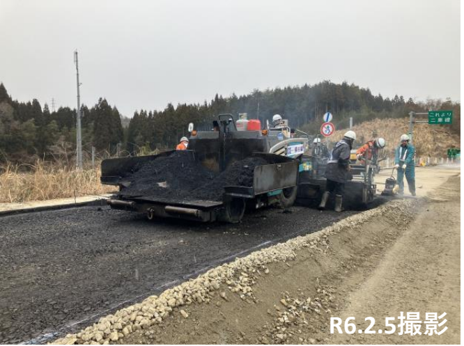
No.29～30付近 舗装施工状況
