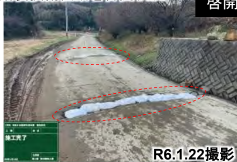
舗装損傷箇所を啓開状況
