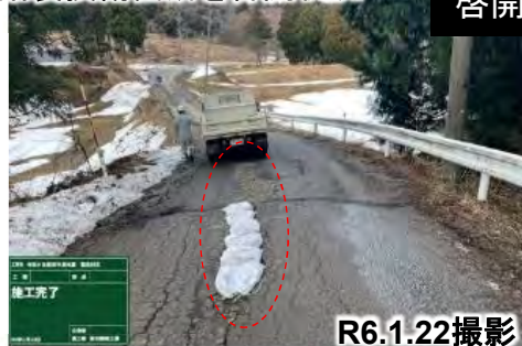
舗装損傷箇所を啓開状況
