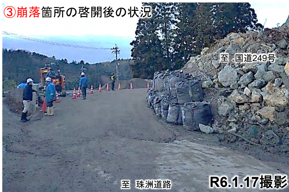
③ 崩落箇所の啓開後の状況
