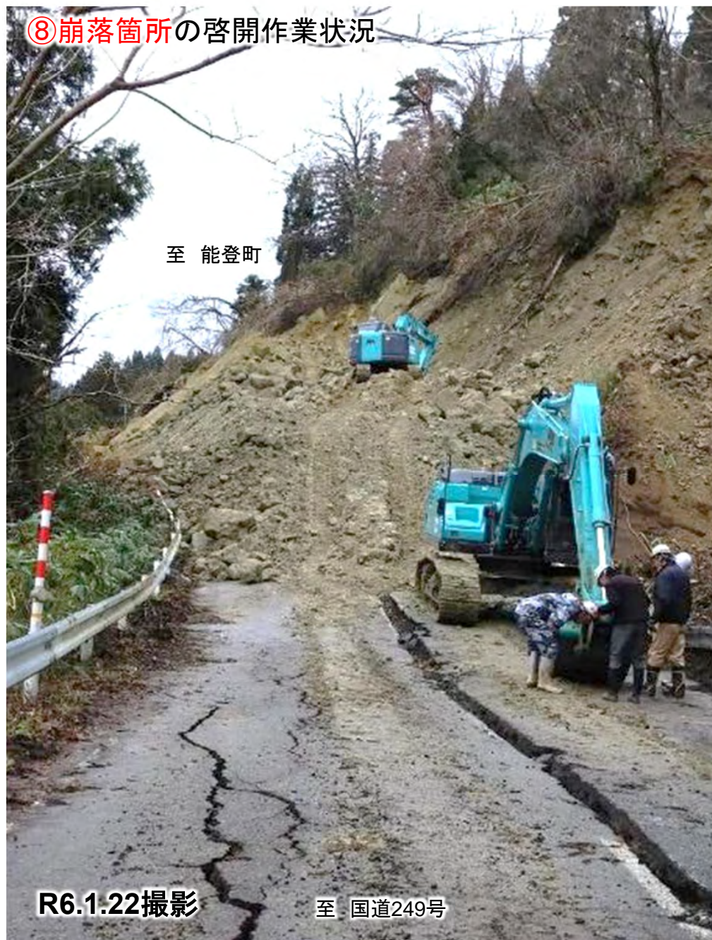
⑧崩落箇所の啓開作業状況
