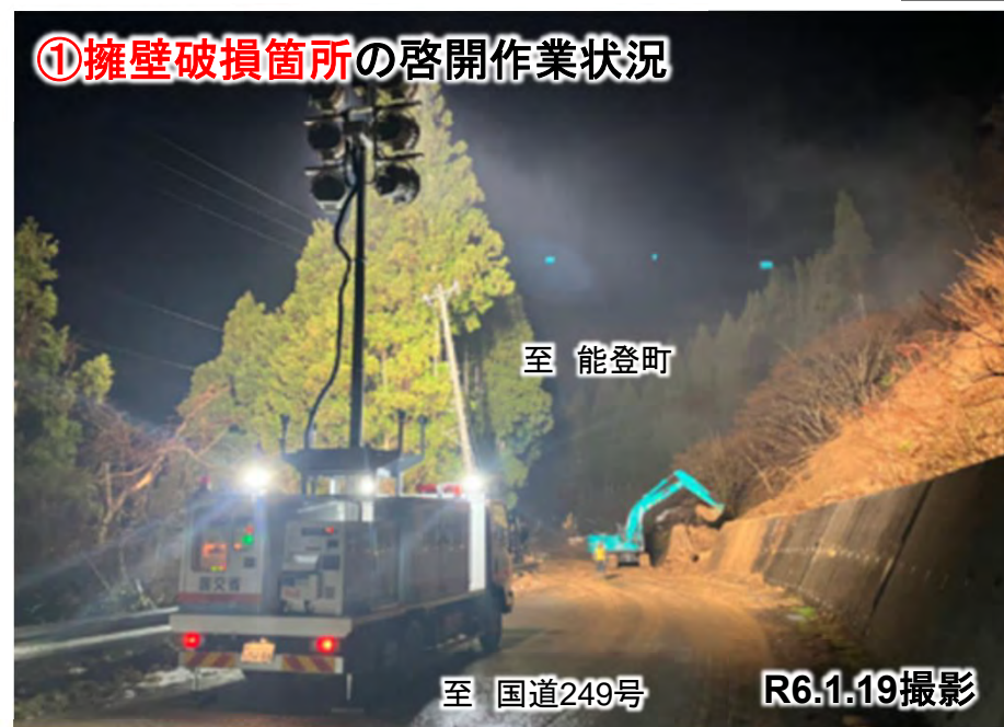
①擁壁破損箇所の啓開作業状況
