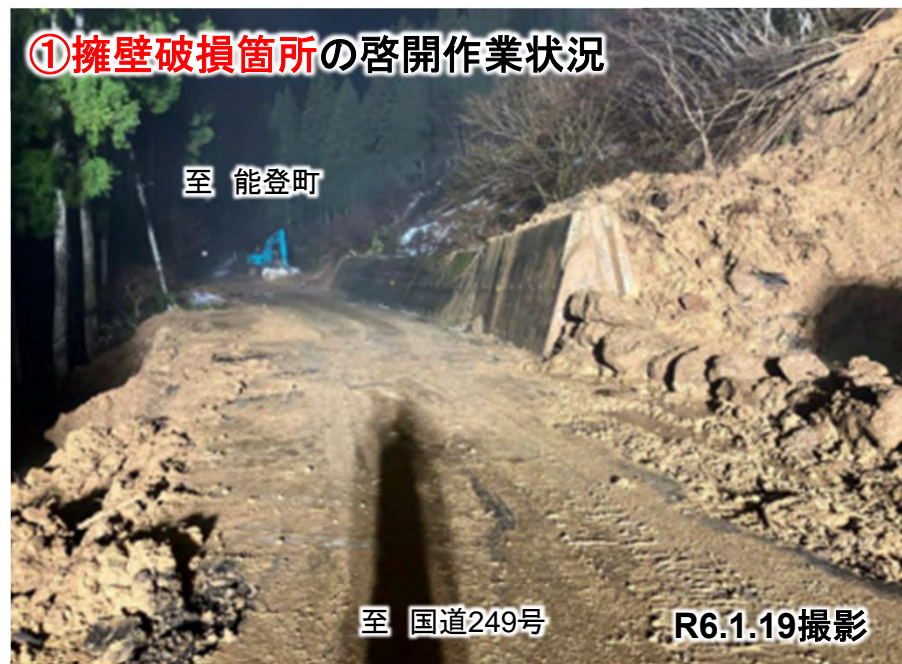
①擁壁破損箇所の啓開作業状況
