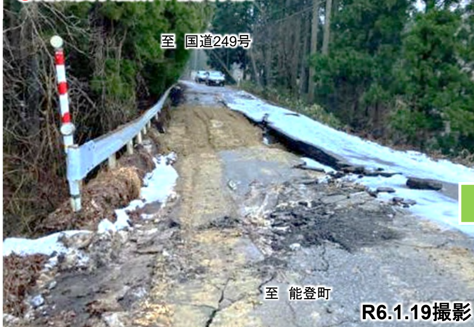
⑦路面変状箇所の被災状況
