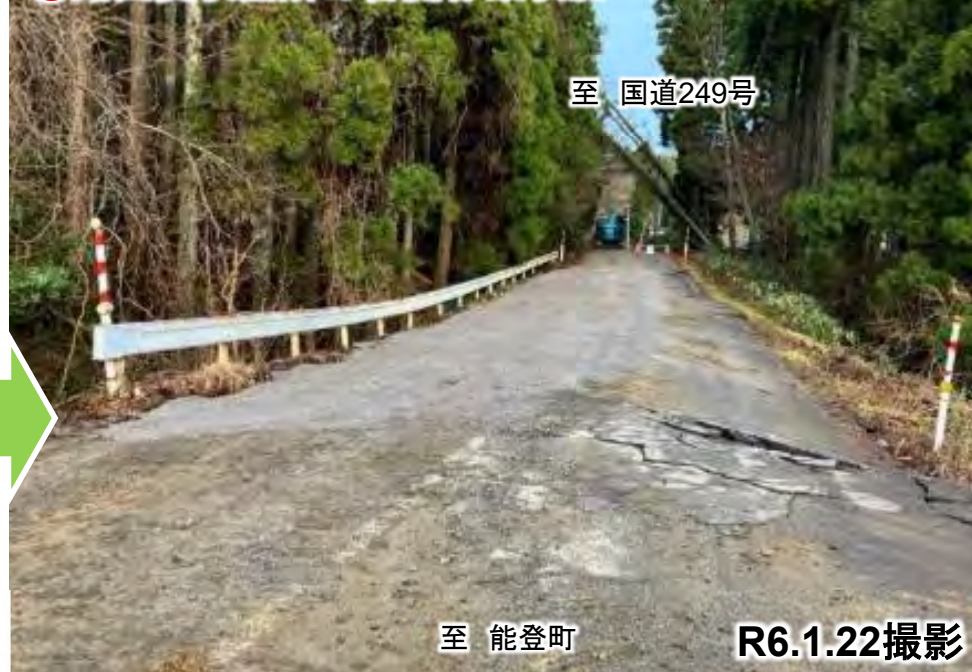
⑦路面変状箇所の啓開作業状況
