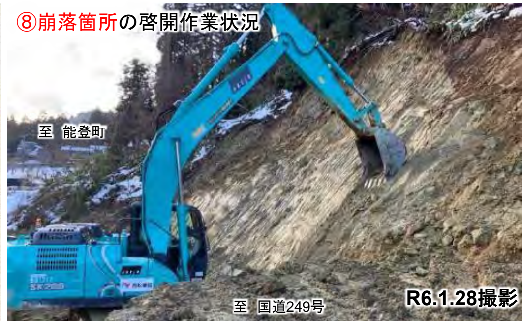
⑧崩落箇所の啓開作業状況
