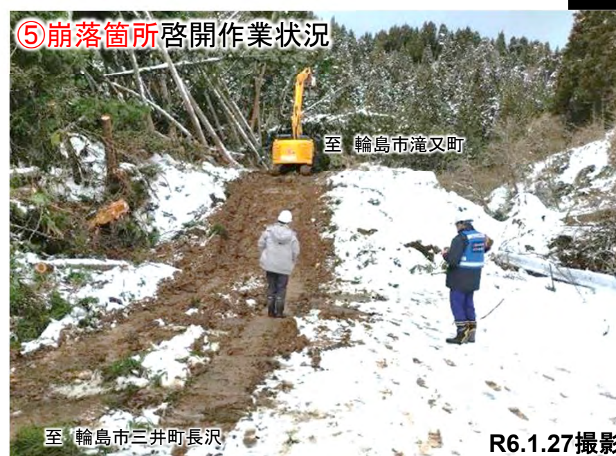
⑤崩落箇所啓開作業状況
