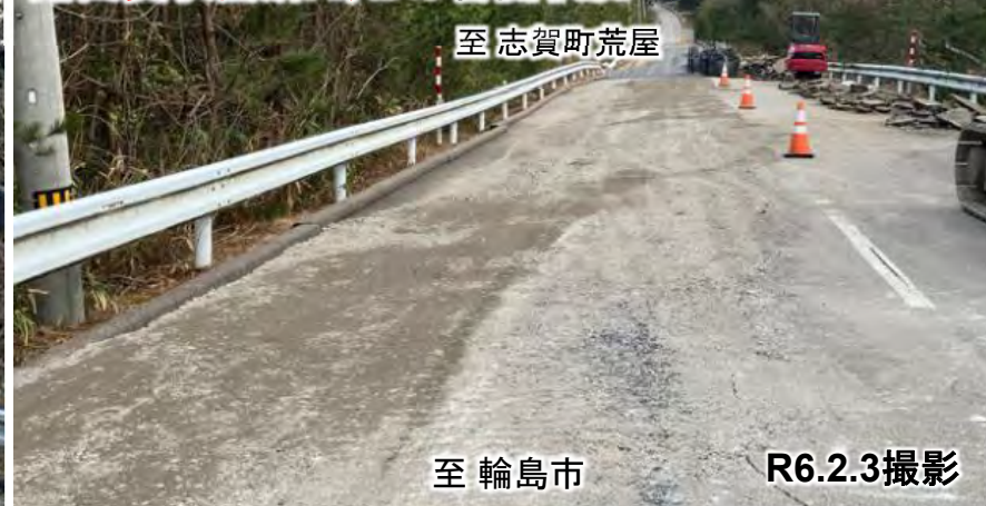
路面変状箇所A、Bの啓開状況
