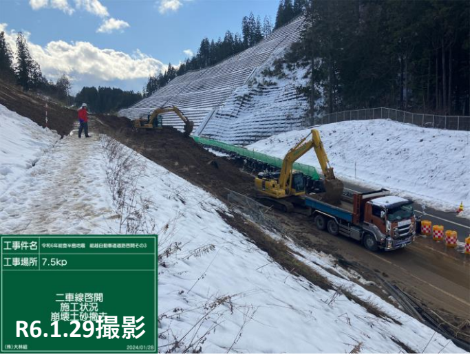
No.3 土砂掘削及び積込状況
