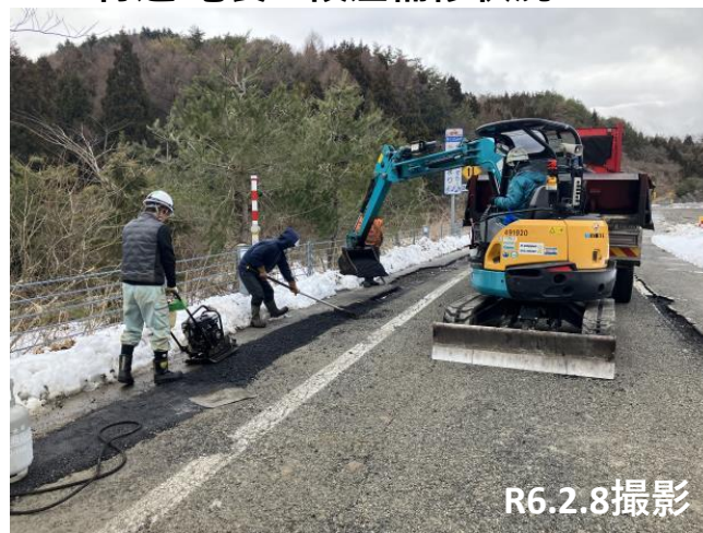
No.4付近 亀裂・段差補修状況
