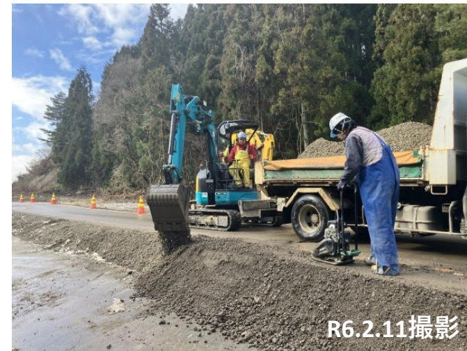
No.24付近 路肩路盤整備状況
