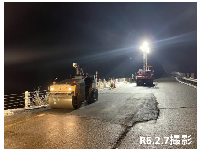
No.34付近 舗装状況
