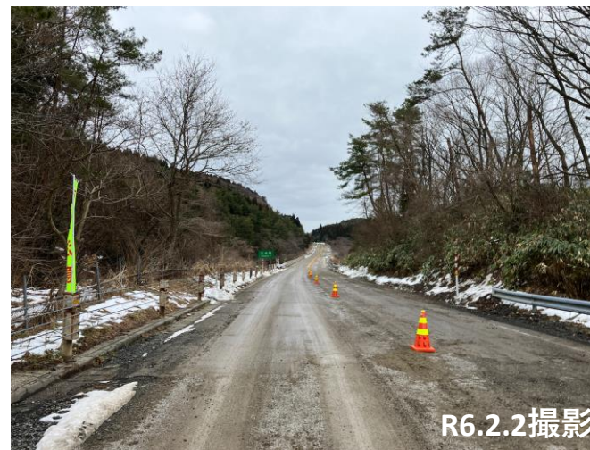
No.7付近 路盤施工状況
