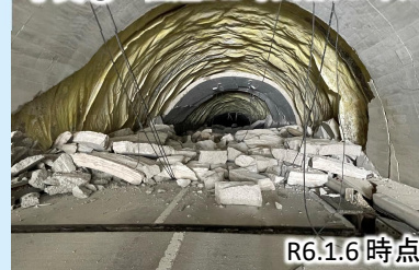
写真⑤ 国道249号大谷トンネル
