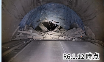
写真① 国道249号中屋トンネル
