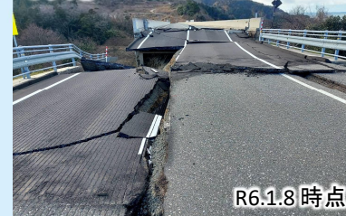
写真④ 国道249号鳥川橋
