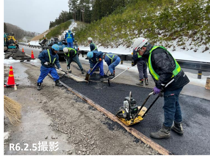
No.18 クラック・段差補修完了
