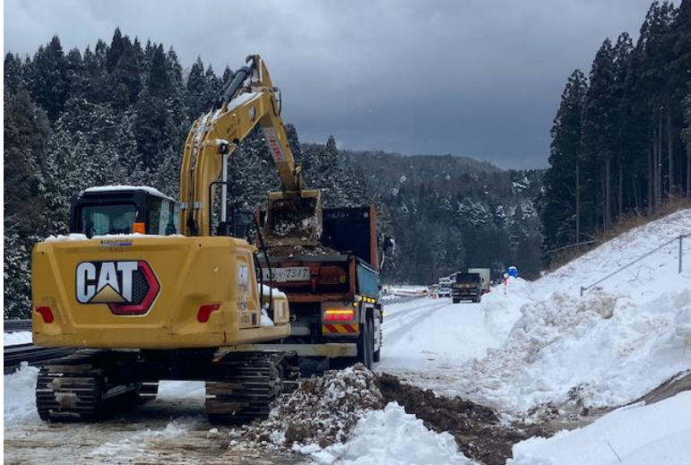
No.3 土砂積込運搬状況
