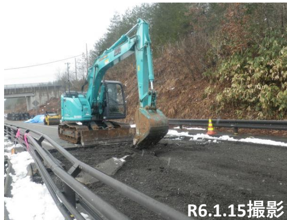
No.6段差復旧状況
