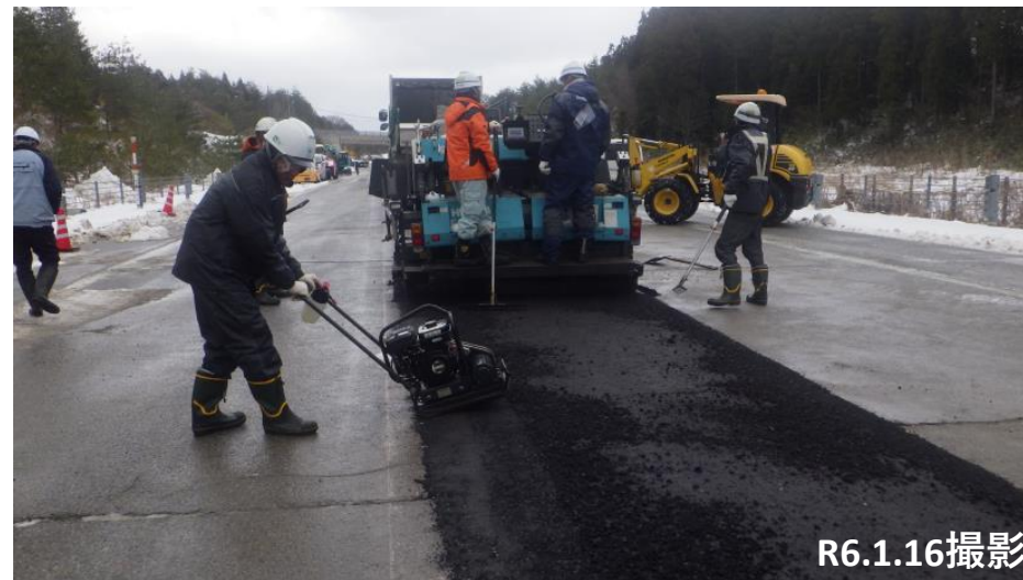
No.6 路面亀裂、段差復旧状況
