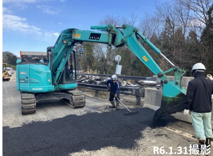
No32 舗装状況
