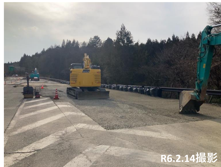
No.56 舗装撤去・砕石埋戻し
