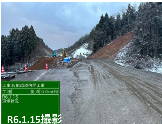
No.16 法面切土
