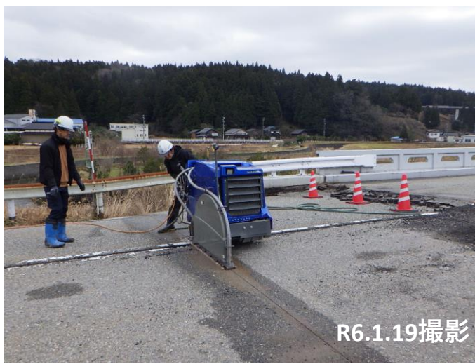
No.6 段差復旧状況
