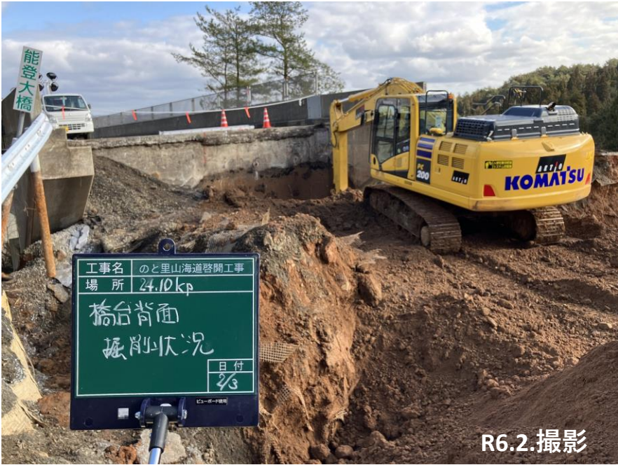
No. 50 橋台背面掘削状況
