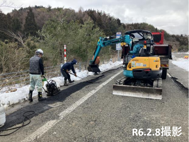
No.4付近 亀裂・段差補修状況
