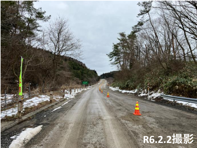
No.7付近 路盤施工状況
