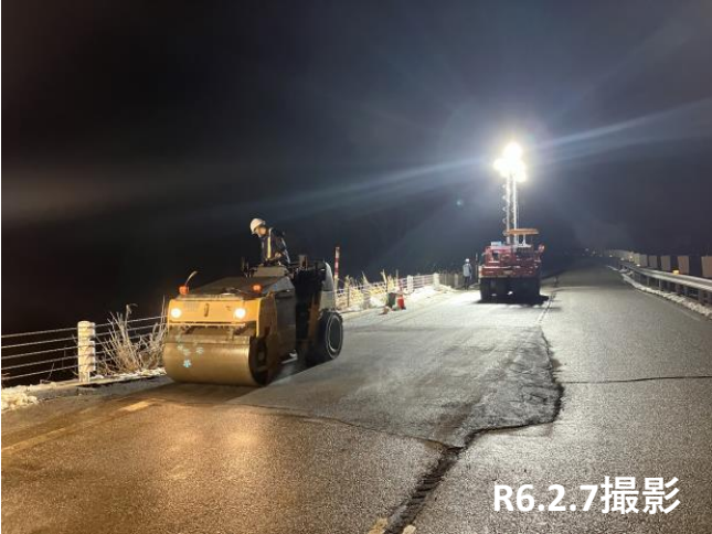
No.34付近 舗装状況
