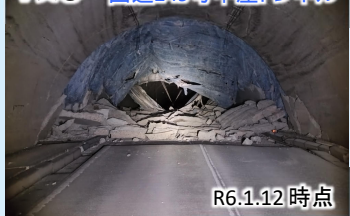
写真⑩ 国道249号中屋トンネル
