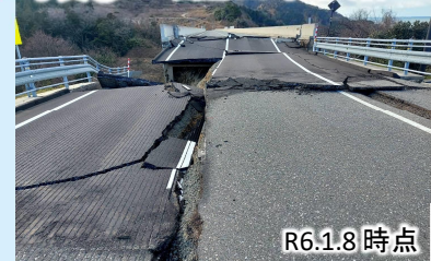
写真④ 国道249号鳥川橋
