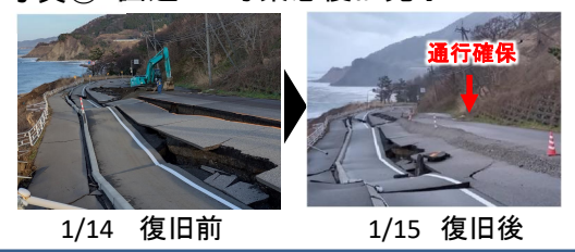
写真② 国道249号緊急復旧完了
