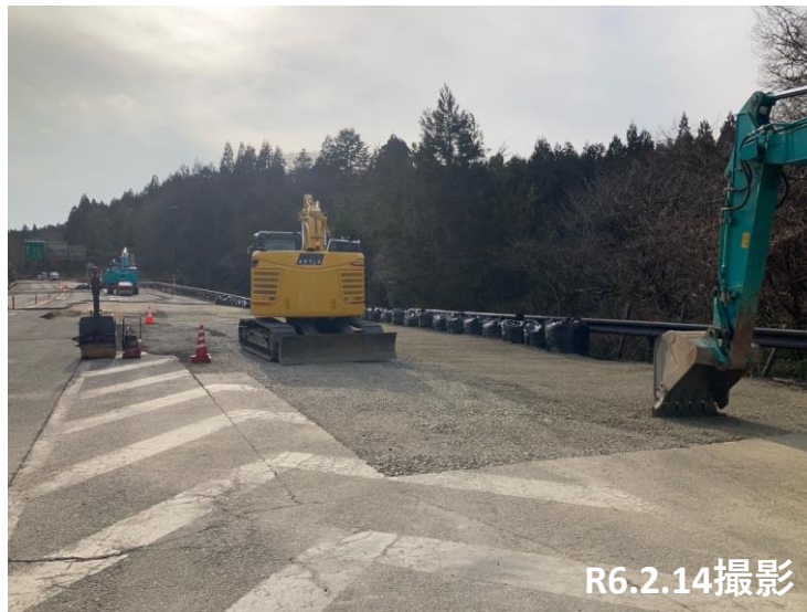
No.56 舗装撤去・砕石埋戻し
