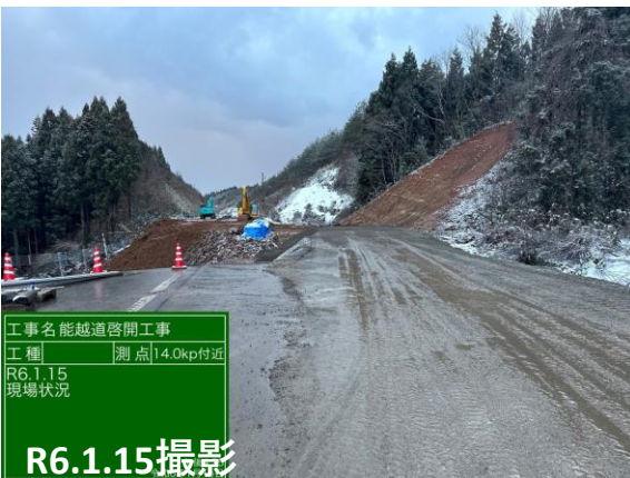
No.16 法面切土
