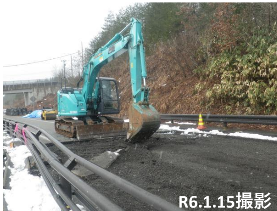
No.6段差復旧状況
