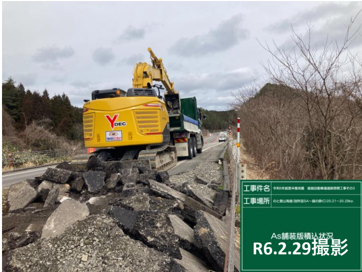
No.35付近 舗装撤去状況
