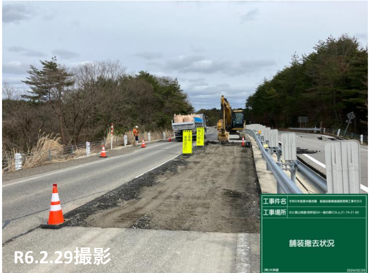
No.35付近 舗装撤去状況
