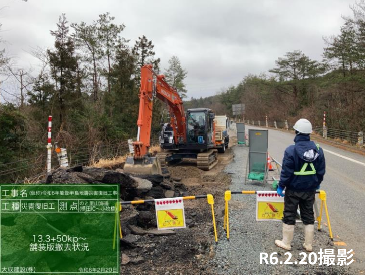
No.10 舗装撤去状況
