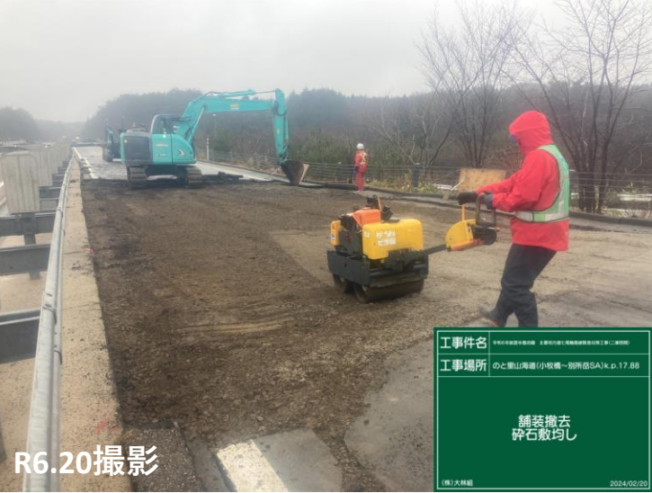
No.44 碎石敷均し状況
