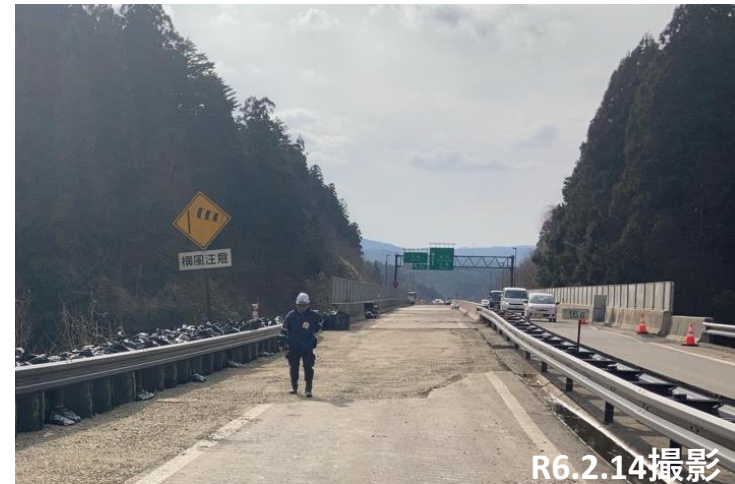
No.40 砕石敷均し状況
