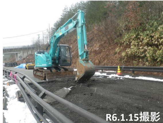
No.6段差復旧状況
