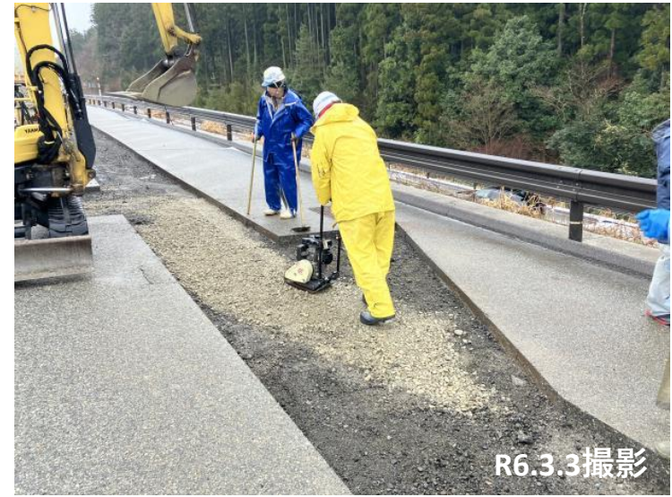
No.44付近 路盤不陸整正転圧状況
