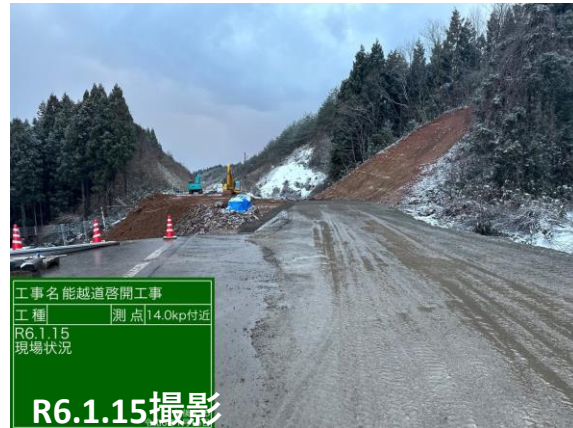
No.16 法面切土
