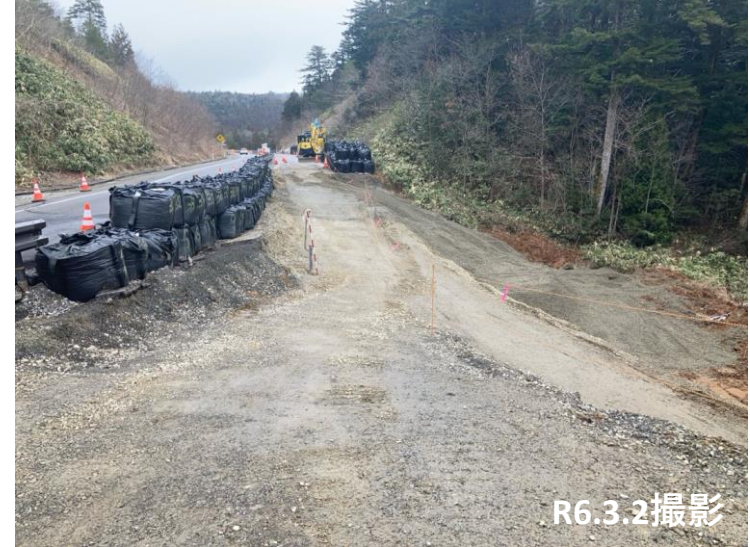
No.44付近 路盤不陸整正転圧状況
