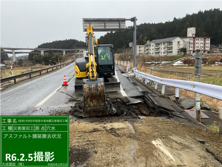
No.42付近 舗装撤去状況
