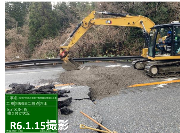
No.56 段差擦り付け
