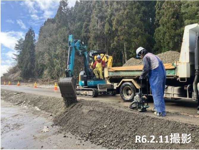
No.24付近 路肩路盤整備状況
