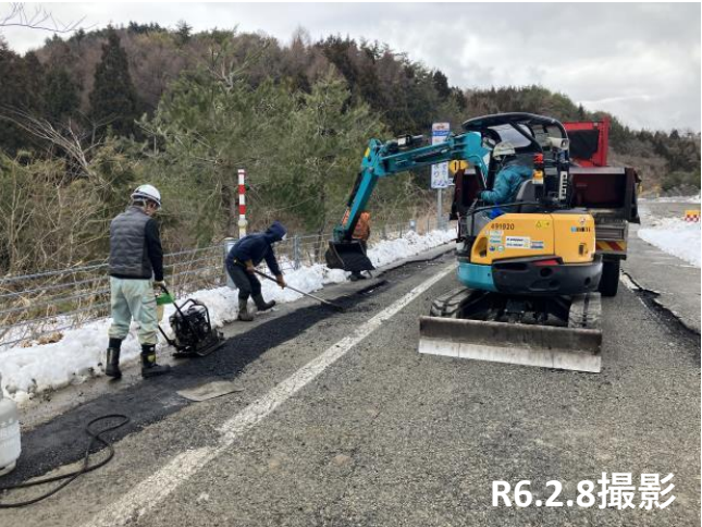
No.4付近 亀裂・段差補修状況
