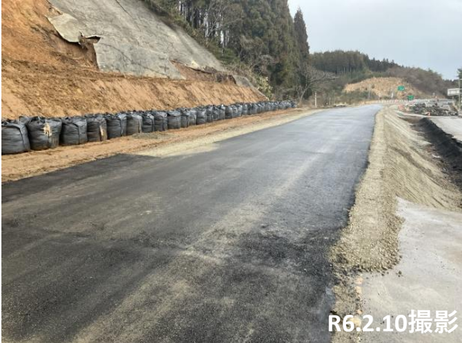
No.29 路盤整備およびAs舗装完了
