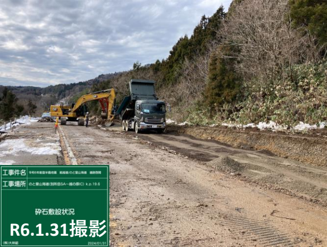
No.16 砕石敷設状況
